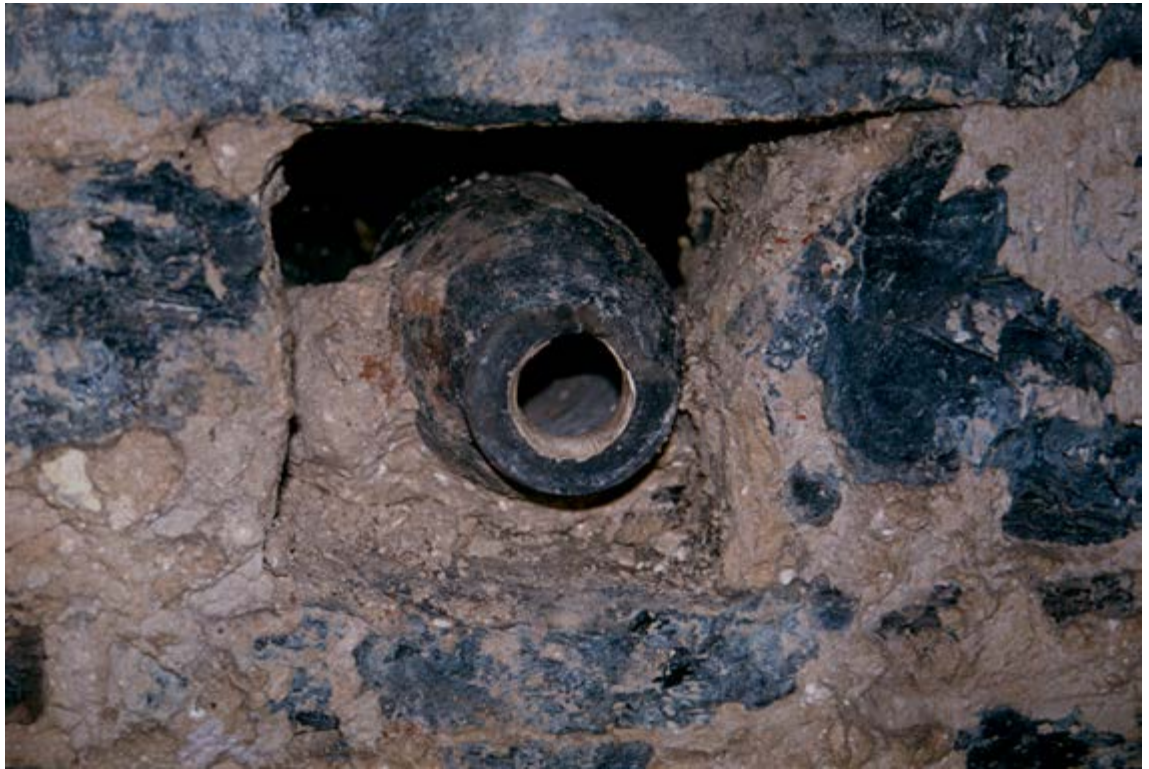
Fig. 2: Flesjes in grijs aardewerk, ingemetseld in de steigersgaten van de binnenwanden in Doornikse steen van de hospitaalkapel, archeologisch onderzoek 1992 (© Stadsarcheologie Gent).
