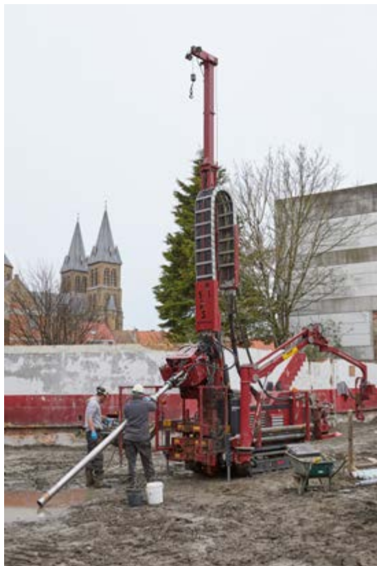
Fig. 1: De door Geosonda Environment NV bij het onderzoek ingezette Aqualock 100 mm op het perceel Torhoutsesteenweg 133 te Oostende (© agentschap Onroerend Erfgoed, foto: Kris Vandevorst).
