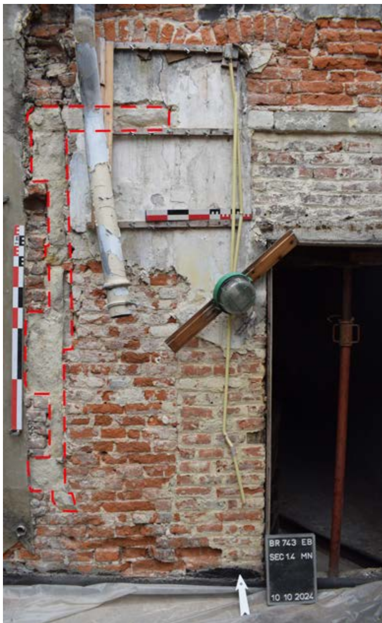
Fig. 3: Piédroit occidental d'une baie à croisée, EB, S. 1.4, MN. Cliché de F. Van Boxem.
