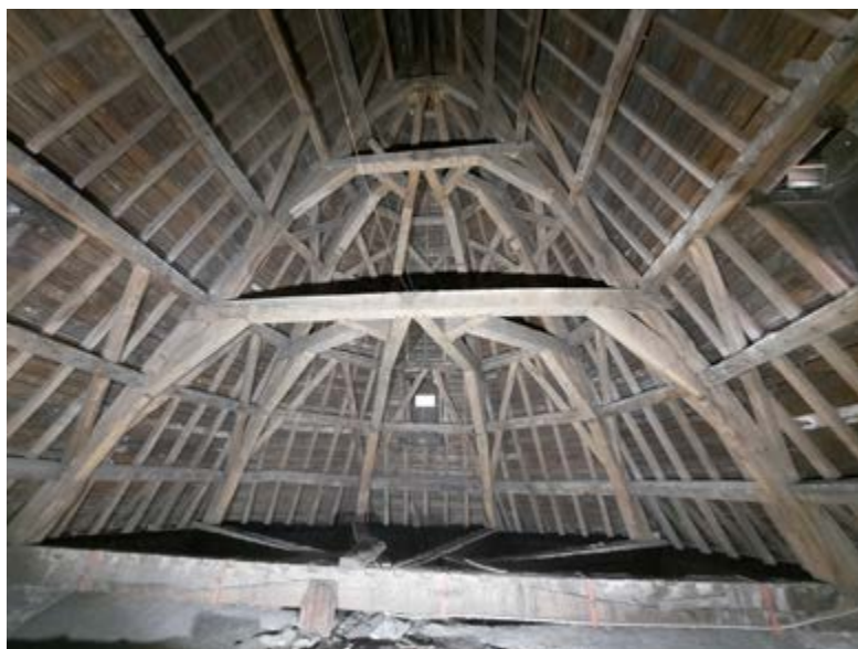
Fig. 2: Vue sur la charpente du chœur de l'abbatiale datée de 1599d par dendrochronologie (ULg, 2005). On y aperçoit les demi-fermes I et II formant l'abside 5/10 et, à l'avant plan, la première ferme complète – la ferme III de la série orientale. MRAH - © urban.brussels, 2024.
