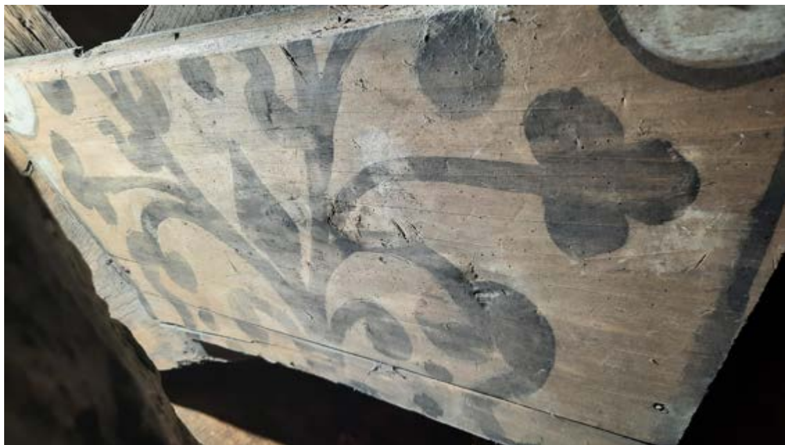
Fig. 3: Partie de plafond en peuplier préservée dans l'abside du chœur. MRAH - © urban. brussels, 2024.
