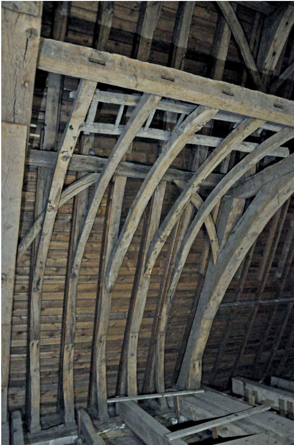
Fig. 3 La charpente de la nef de la chapelle de Marie-la-Misérable – vue sur le versant nord, ©MRAH-IRPA-urban.brussels, 2020.
