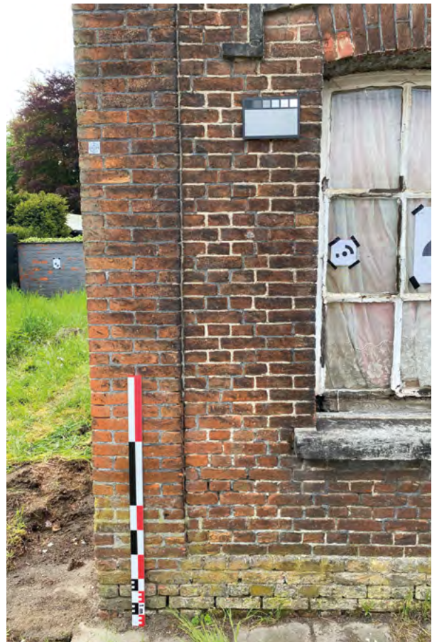
Fig. 4 Détail de la façade nord avec les joints de mortier noir formant un décor différencié sur les pilastres et le reste des maçonneries du premier bâtiment (P. Sosnowska © ULiège)
