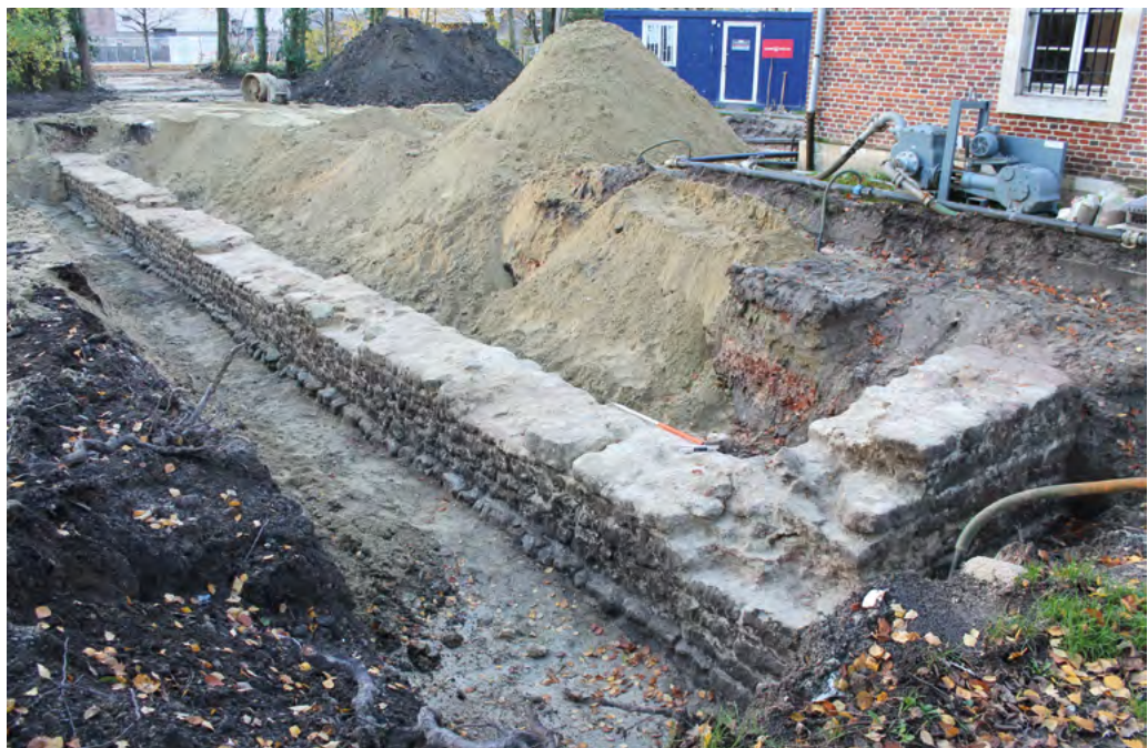
Fig. 3 Mur gouttereau sud et pignon est de la grange abbatiale du XVIII e siècle. Photo : MAH 2023 – ©urban.brussels.
