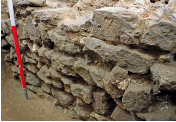
Fig. 2 Fundament zuidmuur van het romaans schip.
