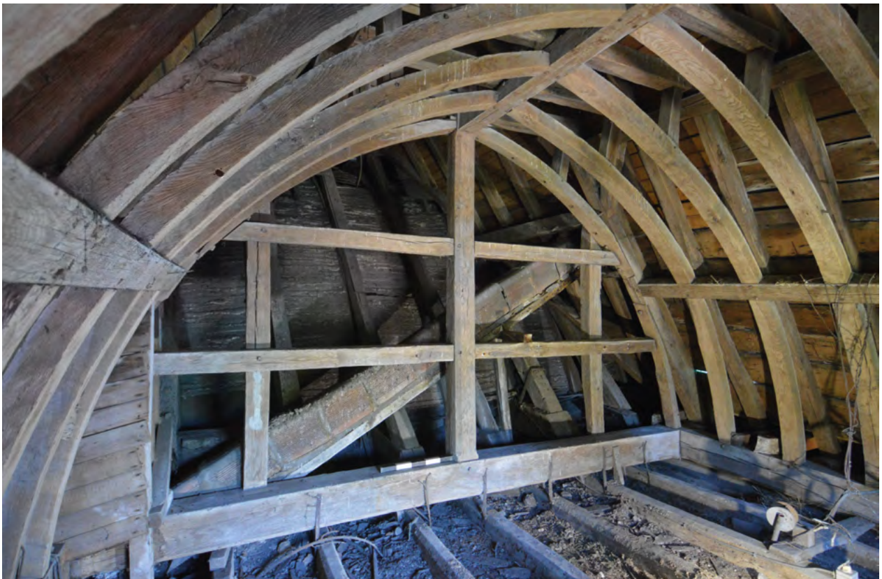
Fig. 2 Charpente en berceau de la chapelle Nord de l'église (Photo M. Verbeek ©AwAP).
