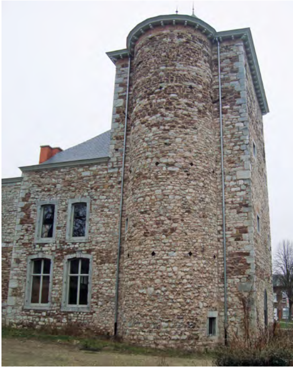
Fig. 2 Vue du donjon avec la tourelle ouest. (Photo. Ph. Mignot).
