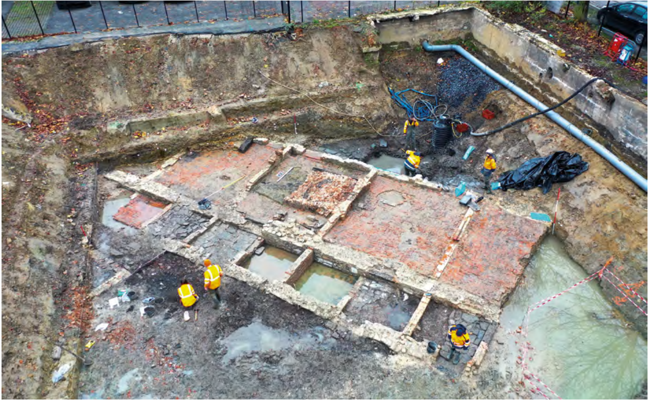
Fig. 2 Maubeuge « La Clouterie » 2022/2023. Secteur 3. Vue du béguinage des XVI e et XVII e siècles en cours de fouille. Photo A. Henton, Inrap.
