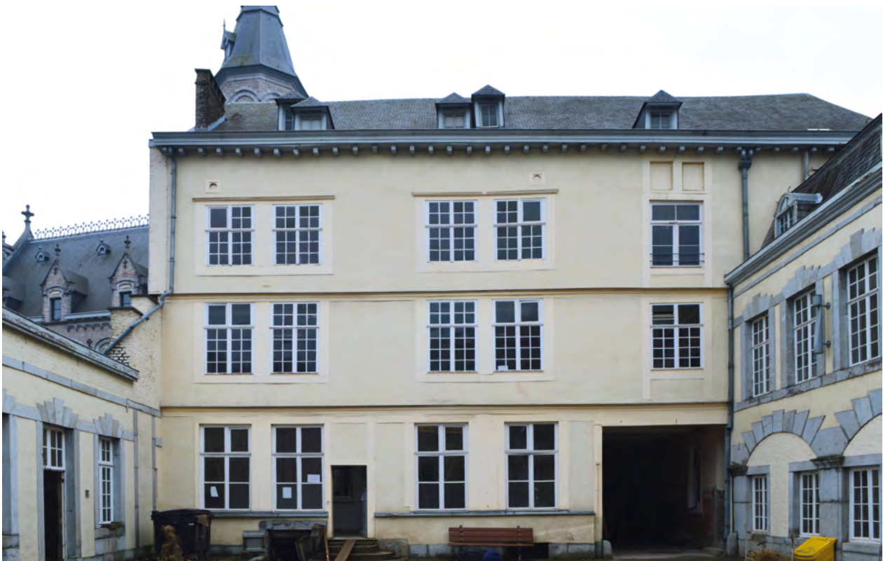
Fig. 1 L'ancien orphelinat des filles, façade côté cour (©AwAP).
