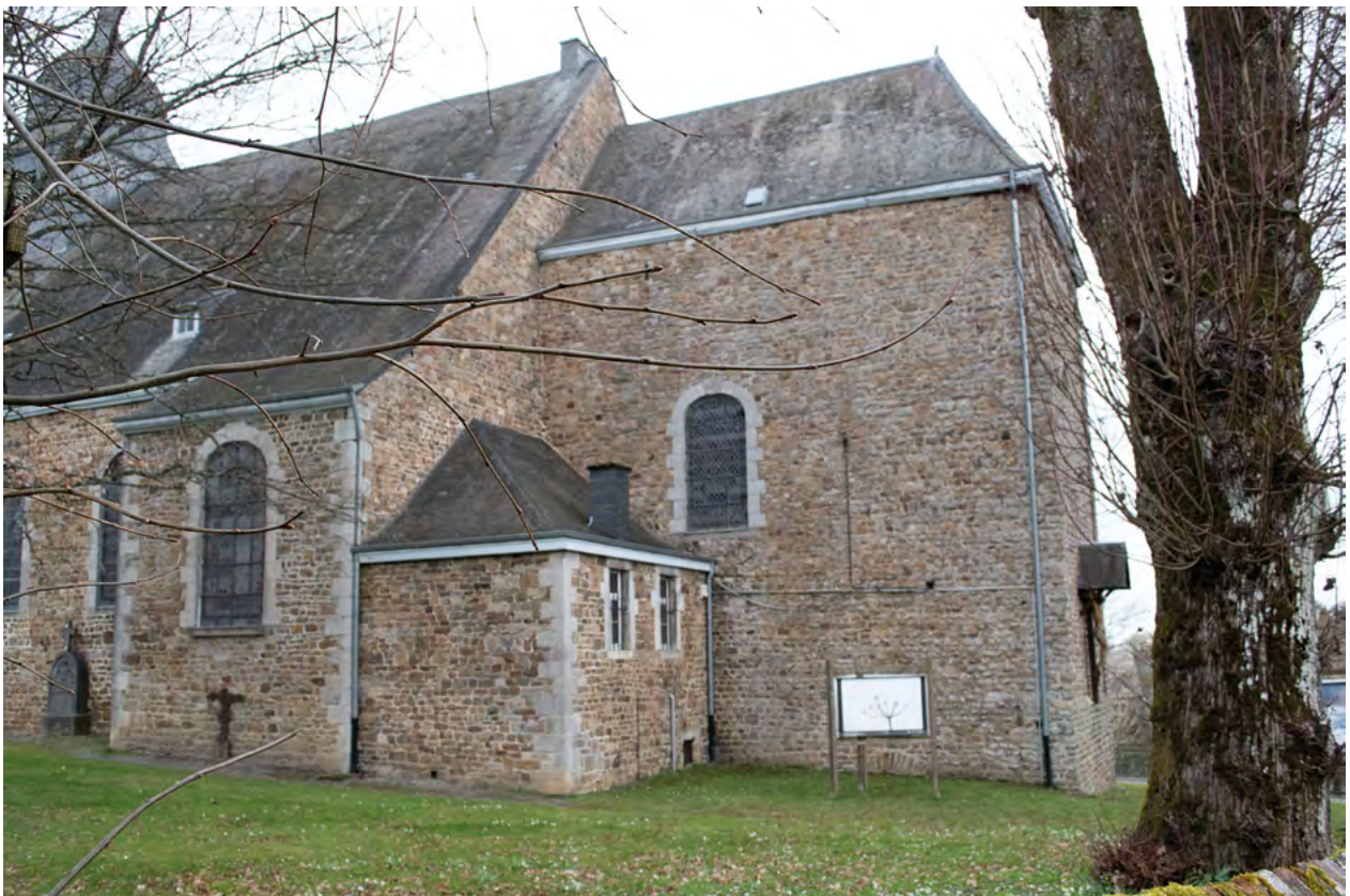
Fig. 1 Nassogne, collégiale Saint-Monon. Vue de la sacristie construite sur caves, contre le bras du transept sud et le chœur. Photo. Ph. Mignot
