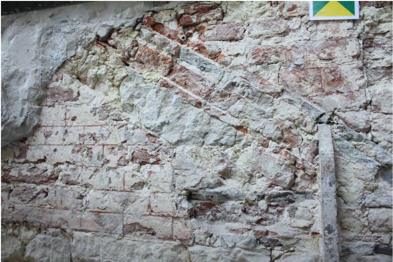
Fig. 2 Vestiges du fronton triangulaire du premier étage (photo A. Baudry © urban.brussels-ULiège).
