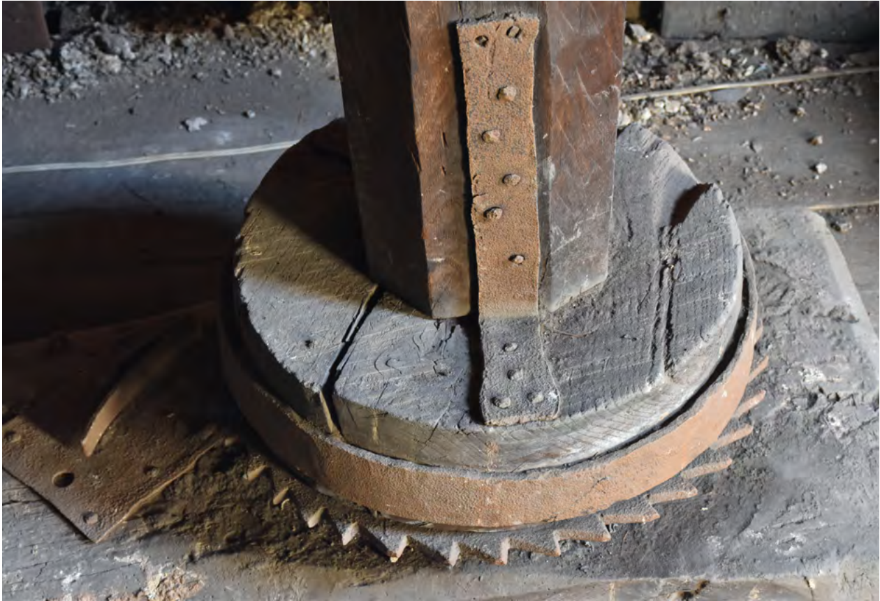
Fig. 3 Détail du cabestan à crémaillère (©AwAP).
