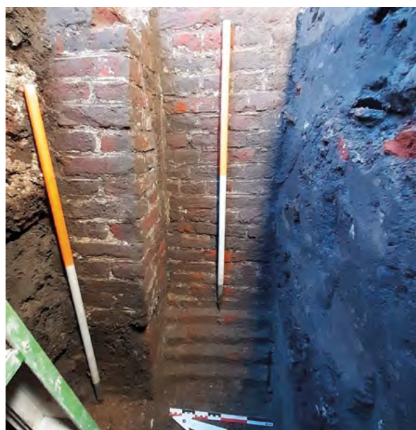
Fig. 2 Fundering (muur met steunbeer) voorloper westelijke stalvleugel (ABO 2023)
