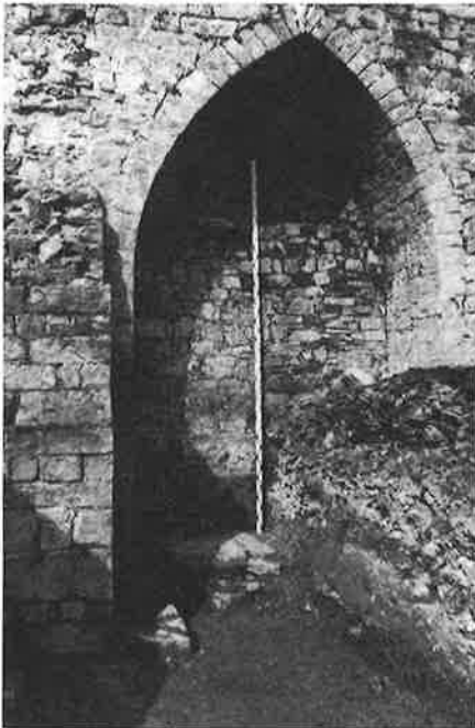
Fig. 19 : BINCHE - Refuge de Bonne Espérance. Un des trois arcs brisés du haut mur en moellons
