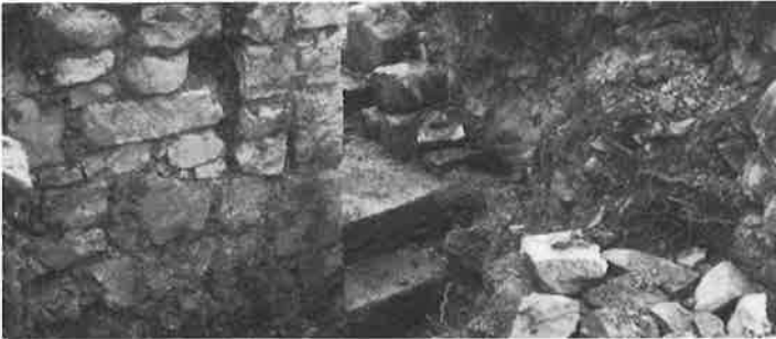
Fig. 12 : FALAEN - Entrée de la cave sous la salle des chevaliers (bâtiments du donjon)
