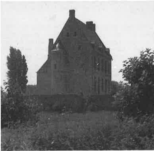
Fig. 7 : MOUSCRON - C'est de ce côté que s'élevait le donjon démoli en 1801
