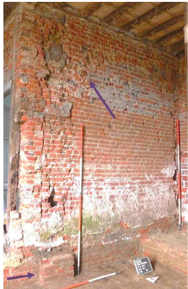
Fig. 2 Werkput 4 (inkom/gang), profiel W met aanduiding van het restant van een graatgewelf (bovenaam) dat grotendeels weggebroken is voor de verhoging van de pastorie en met onderaan een verbreding ter hoogte van de fundering waar de kracht van het gewelf naar beneden werd overgebracht.
