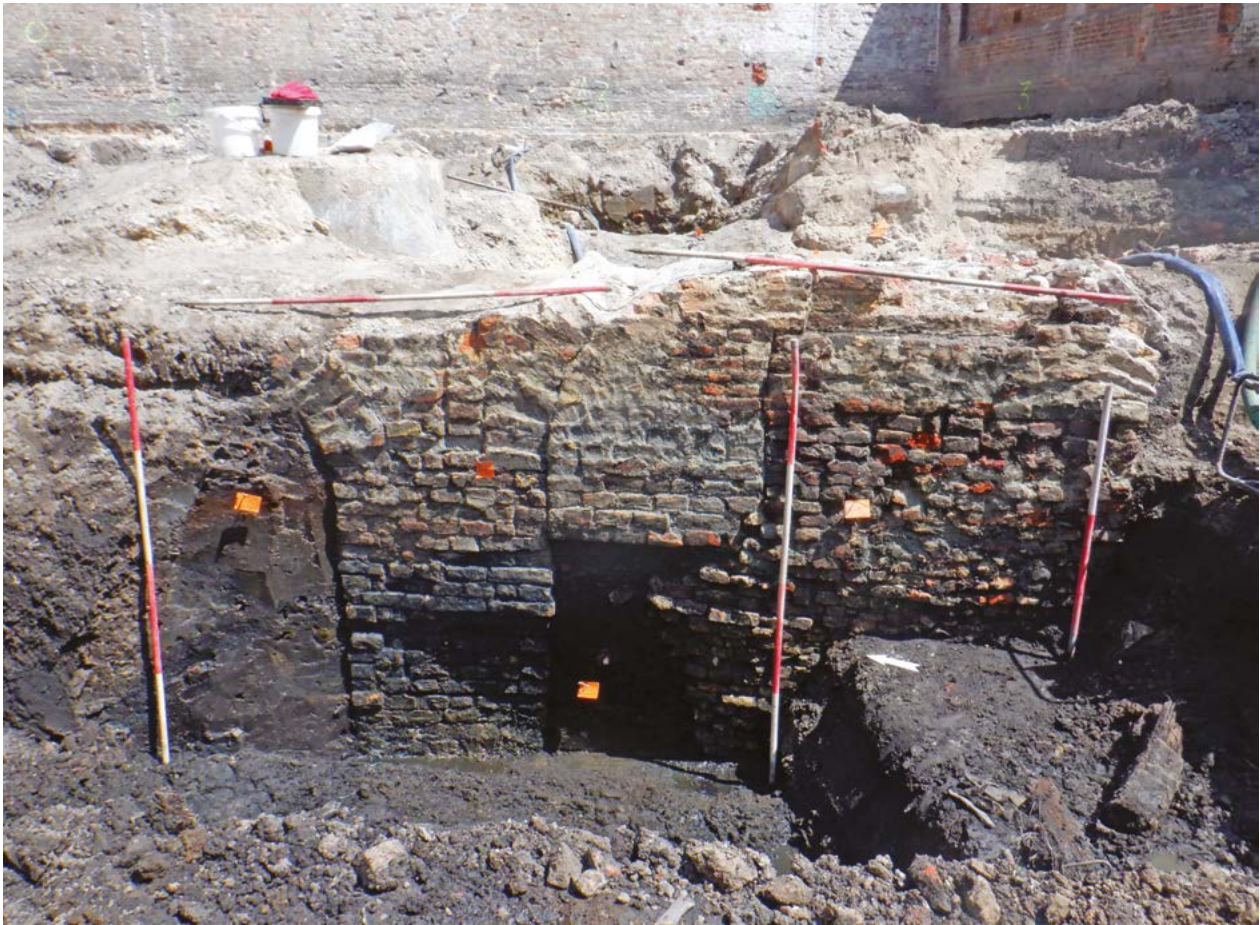
Fig. 2 Spaarbogenvondering die mogelijk de omheiningmuur van het Hof van Moeskroen ondersteunde.
