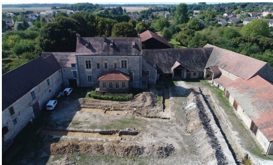
Fig. 1 Vue de la façade sur cour de la ferme du Coulevrain à Savigny-le-Temple, France (Cliché drone R. Touquet, Inrap).
