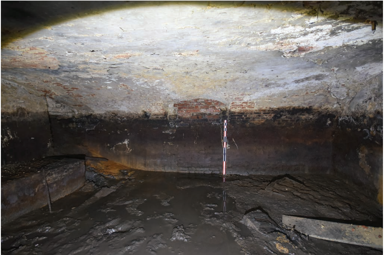
Fig. 3 Photographie du mur sud de la salle nord de la cave de la ferme du Castrum et la baie de porte permettant la communication avec la salle sud (© ULB-urban.brussels ; cliché : Paulo Charruadas).
