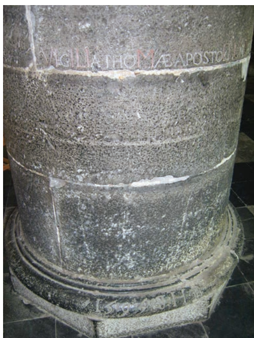
Fig. 1 Marques d'inondations et chronogramme sur une colonne de la collégiale de Dinant.
