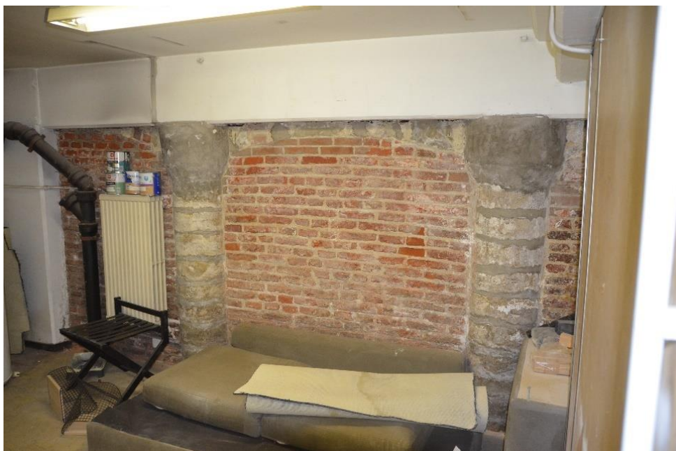
Fig. 3: Photographie des colonnes avec chapiteaux en cave des maisons rue du Marché-au-Charbon 7-9. (© ULB-urban.brussels)
