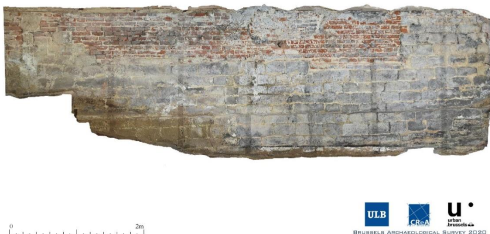
Fig. 2: Orthophotographie du mur latéral nord en calcaire gréseux et briques, visible en cave de la maison rue de l'Étuve 47, mais ayant dû appartenir à la maison voisine du 45. (© ULB-urban.brussels; DAO: Benjamin Van Nieuwenhove)
