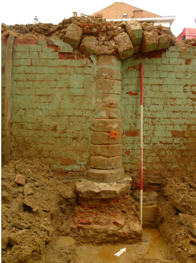
Fig. 2: Bewaarde natuurstenen zuil met aanzet van de dragende ribben in een kelder aan de Onze-Lieve-Vrouwestraat.
