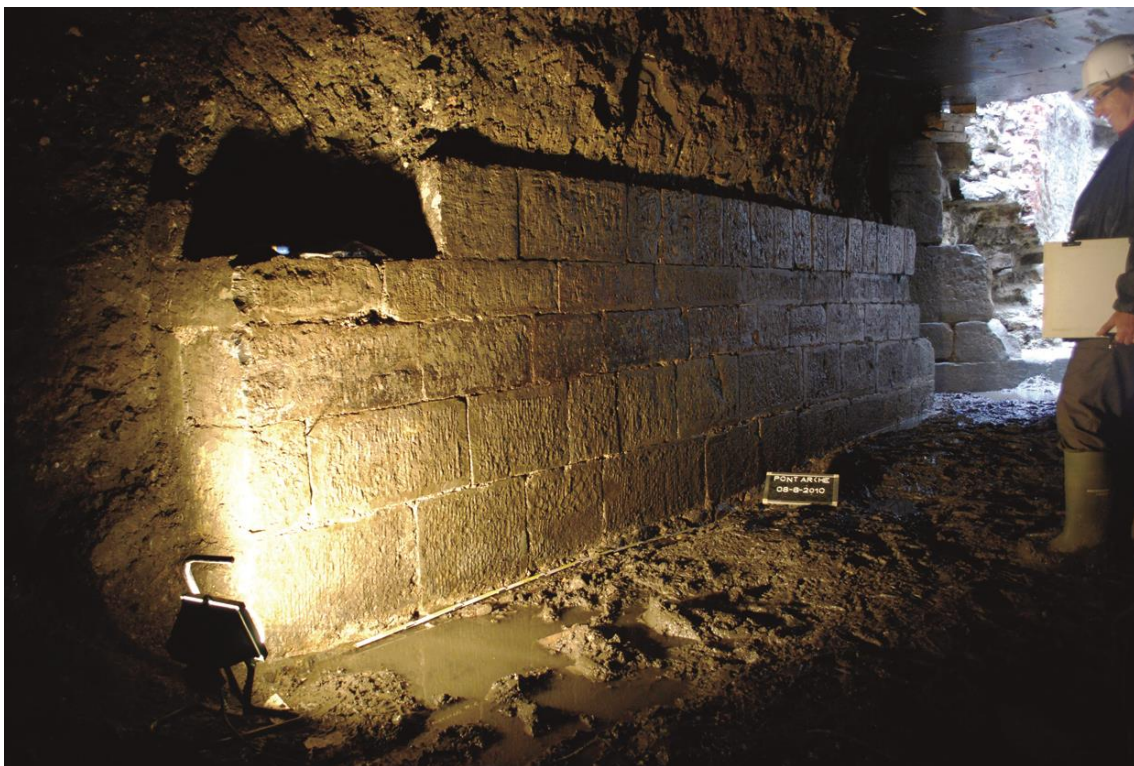
Fig. 3: Maçonnerie M32 au contact de l'avant-bec de la première pile du pont.
