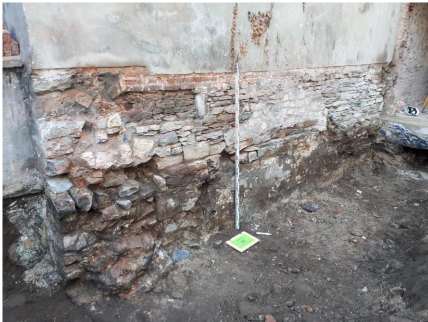
Fig. 2: Aanzet OW georiënteerde muur, opgebouwd uit Doornikse kalksteen. (©Ruben Willaert nv) (met dank aan Stad Gent, Dienst Stadsarcheologie en Monumentenzorg).
