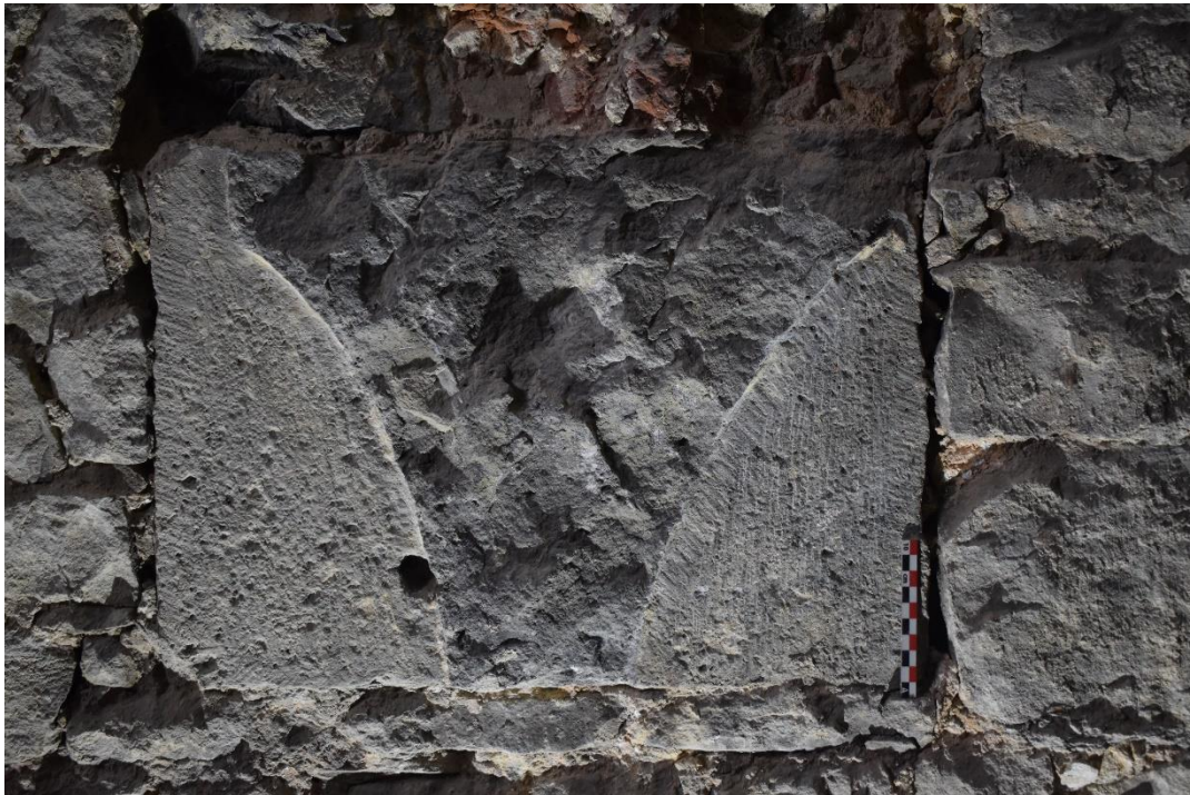
Fig. 2: Culot en grès dolomitique (49 x 35,5 cm) présentant des traces de taillant droit, placé au centre du trumeau des fenêtres médiévales (XIII e siècle) de l'aile est du cloître. (© AWaP - Musée Art & Histoire – 2020)
