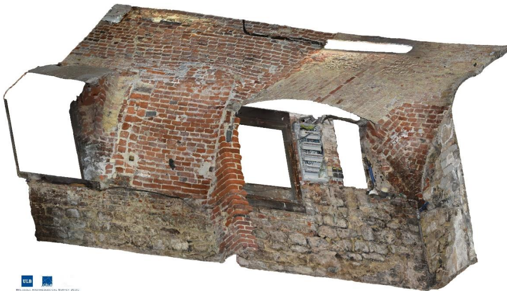
Fig. 1: Axonométrie de la cave de la maison rue du Marché-aux-Fromages 3, montrant les différentes phases d'Ancien Régime sur le mur nord, une partie du mur est et sur la voûte. (© ULB-urban.brussels DAO: Benjamin Van Nieuwenhove)
