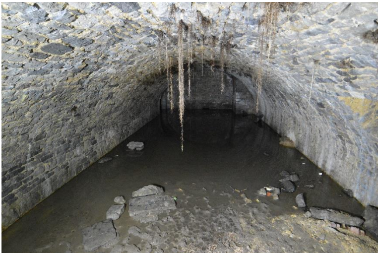
Fig. 3: La salle nord vue vers l'ouest. (P.-H. Tilmant@awap)
