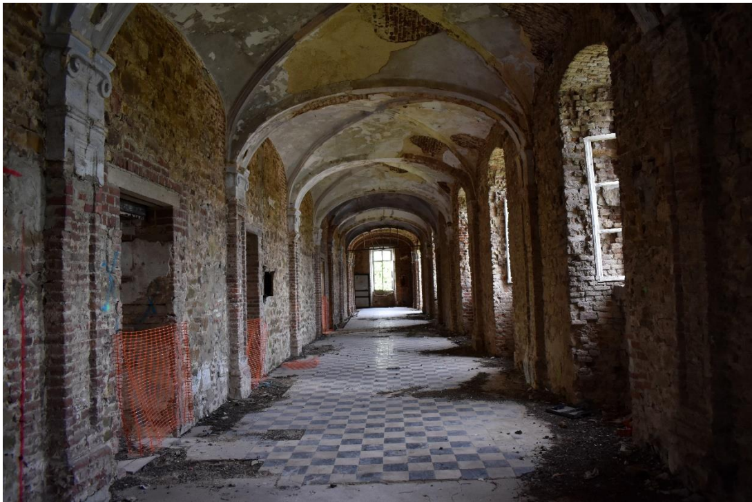
Fig. 3: Galerie de l’aile Sud du cloître au premier étage, vue depuis l’Est. (© AWaP - Musée Art & Histoire – 2020)
