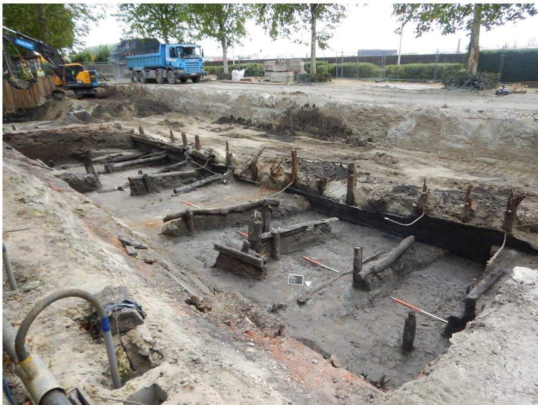
Fig. 1: Overzicht van de kade met houten verankeringen in het noordoosten.
