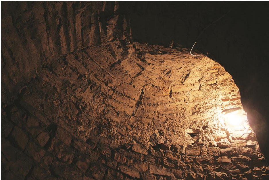
Fig. 2: Intrados du berceau de voûte dans les parties basses de l'escalier de la tourelle nord avec le négatif des planchettes de coffrage. (photo Antoine Baudry & Aline Wilmet)
