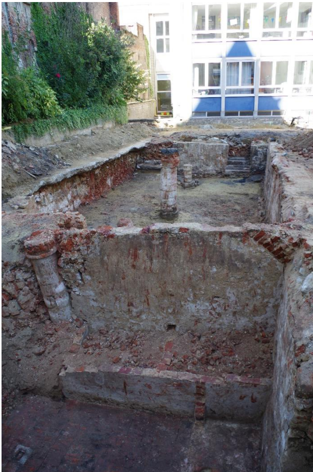
Fig. 1: Overzichtsfoto gebouw 1 vanaf het zuiden. (©Ruben Willaert nv)
