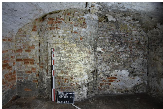
Fig. 2 : Mur sud du secteur 9, rue Haute 83, maçonnerie en moellons et briques, avec niche (© ULB-urban.brussels).
