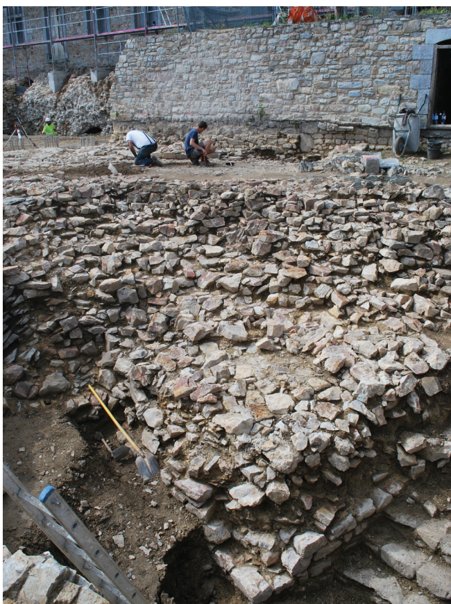
Fig.2 : Nettoyage de l'arase de démolition de la grande tour d'angle.
