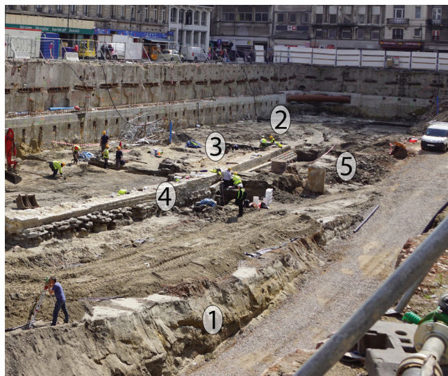
Fig.1 : Vue du chantier de la moitié sud du chantier. 1 : Niveaux pré-holocènes / 2 : Anciens lits de Senne VIII-XII e siècle / 3. Berges XIII-XIV e siècle / 4. Quai XIV-XIX e siècle / 5. Senne canalisée XIV-XV e siècle © urban.brussels.
