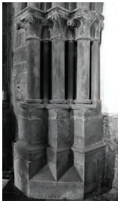
Fig. 2 : Détail du piédroit nord. Les maçonneries sous la moulure en doucine, moulure y compris, ont été restaurées au XIX e siècle.
