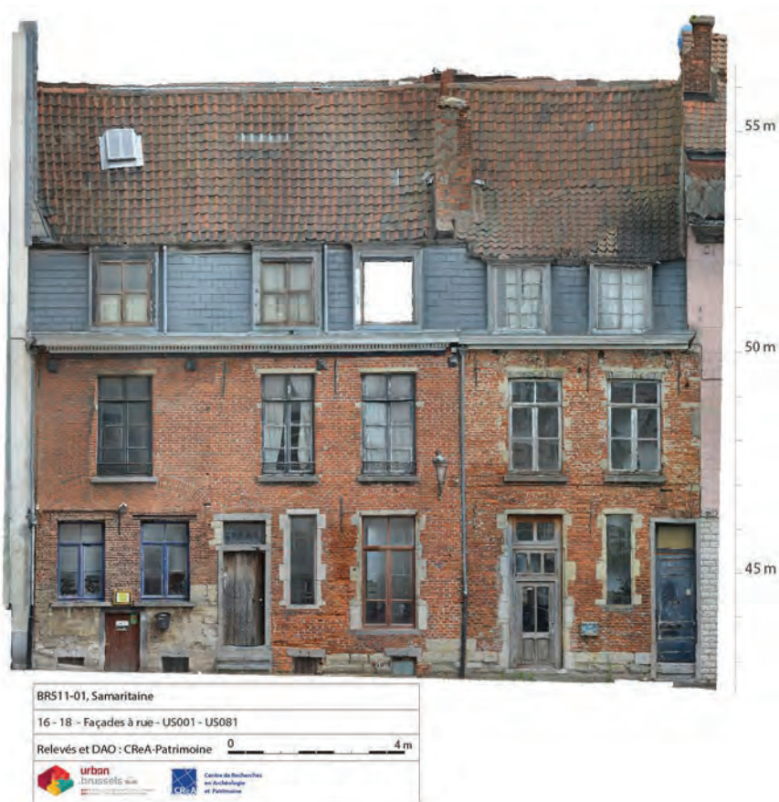
Fig. 2 : Façade avant des maisons n°s 16 et 18, relevé photogrammétrique (A. Darchambeau © urban.brussels & ULB).
