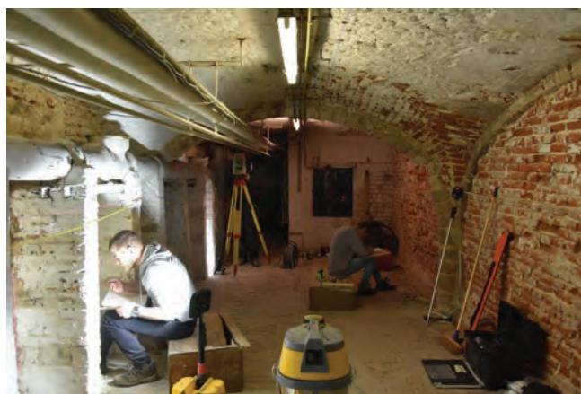
Fig. 2 : Vue de la cave de la maison rue de la Tête d'Or 5 en cours d'étude par l'équipe et des étudiants de l'ULB et l'UNamur.
