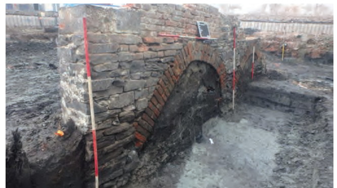
Fig. 2: Fundering van het 13de-eeuwse Steen230, met een duidelijk zicht op de spaarbogen waarbij gebruik werd gemaakt van zowel baksteen als natuursteen. Foto richting noorden (© BAAC bvba).
