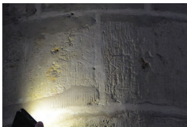
Fig. 3 : Marques lapidaires. Exemple de deux marques visibles à hauteur d'homme sur deux tambours voisins d'une colonne du chœur.
