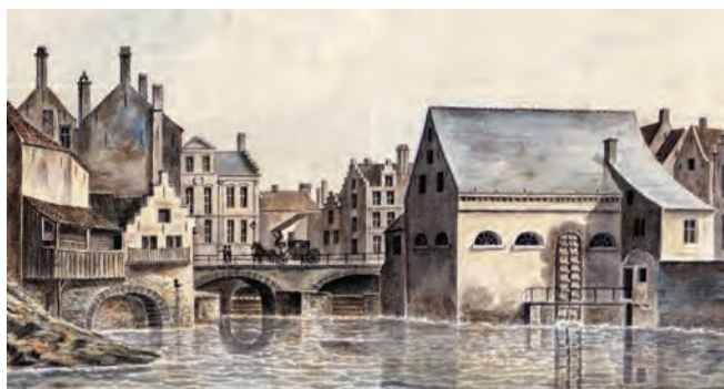
Fig. 1: De Braamgatenstuw (links) aan de Brabantdam op de Schelde, met de stadswatermolen (rechts), Wynantz 1820-23 (Stad Gent, Archief Gent, SAG W 067).
