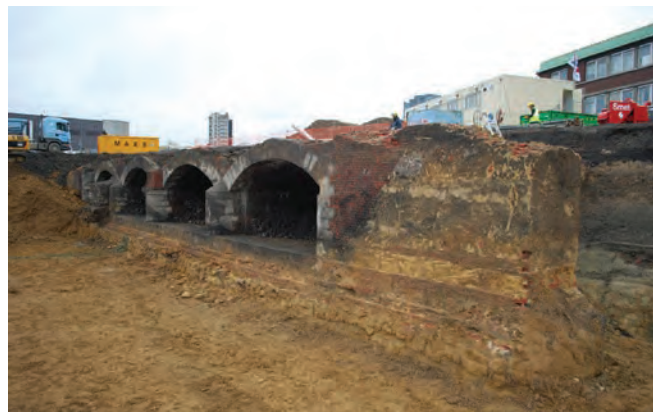
Fig. 1 : Charleroi, le pont ferroviaire en cours de dégagement. Photo © AWAP/Dir. Opérationnelle Zone Ouest.
