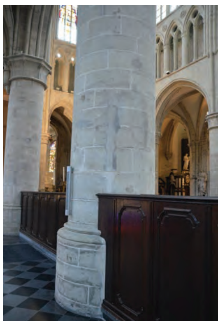
Fig. 2 : Une colonne du chœur. Composées d'environ seize assises à tambours superposés, les colonnes ont été observées jusqu'à la hauteur de la septième assise depuis la base.
