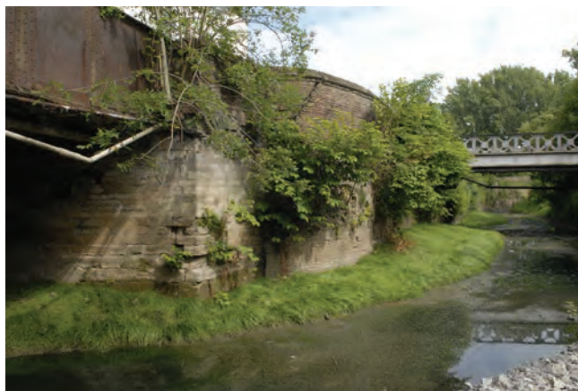
Fig. 3 : Le Pont d'Aa sur la Senne à Anderlecht © urban.brussels.
