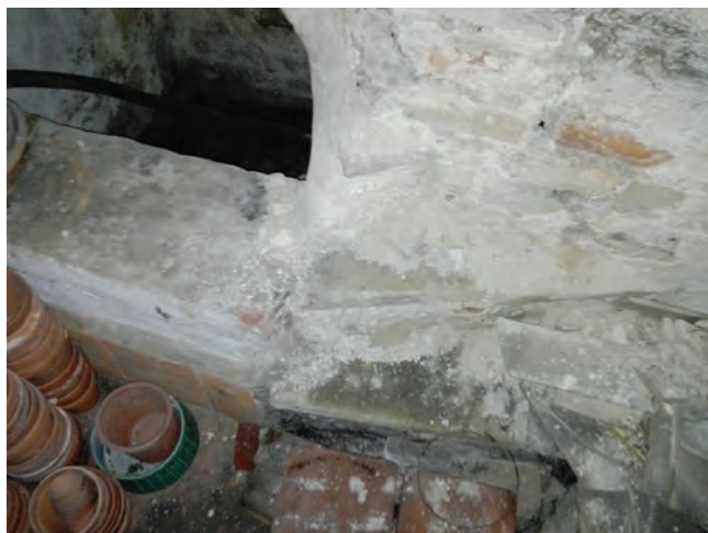
Fig. 4: Restanten van een witstenen spiltrap die oorspronkelijk naar een waterput leidde, kelders Godelieveabdij, Brugge; bron: Raakvlak.
