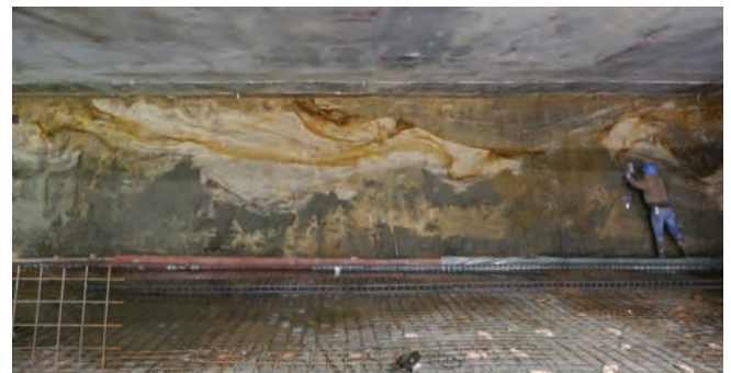
Fig 1 : Les alluvions de la Senne sur le chantier de la rue d'Aerschot à Schaerbeek © urban.brussels.
