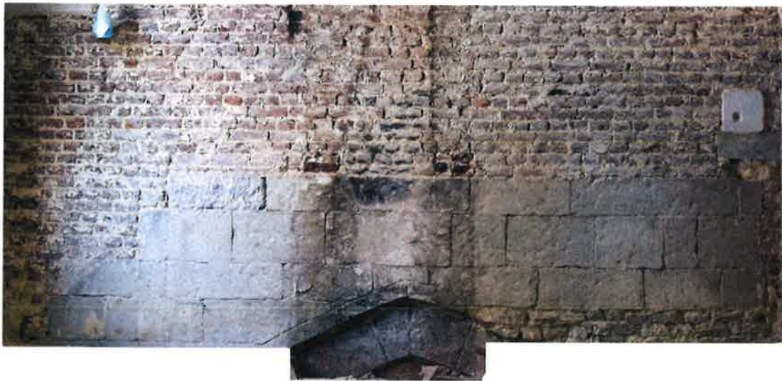
Fig. 2: Arc brisé monumental en Calcaire de Meuse à l'extrémité ouest de la galerie méridionale (photo et infographie: P.-M. Warnier, © SPW-DGO4)
