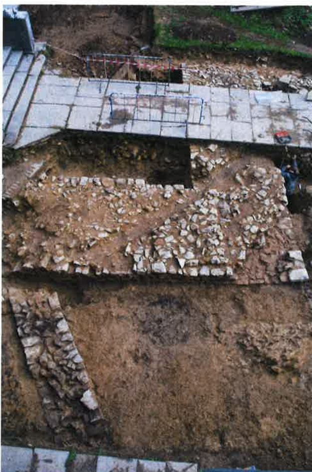
Fig. 2: Vue générale du chantier avec les donjons successifs. © SPW
