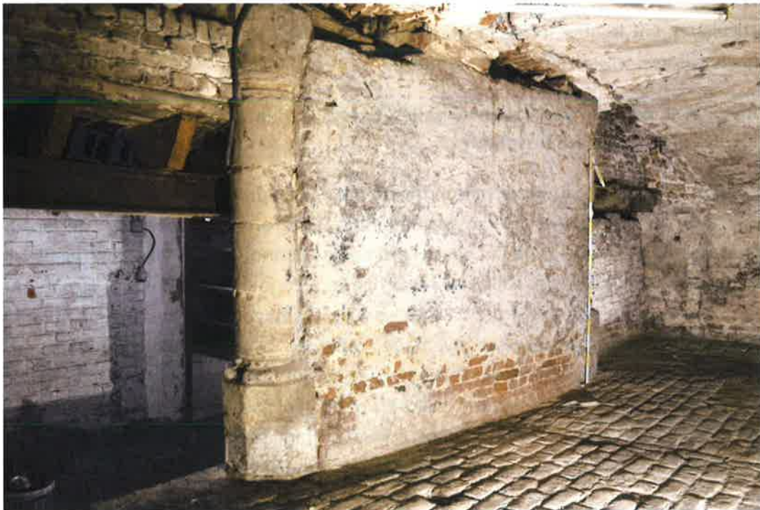
Fig. 1: Vue de la cave voûtée et d'une des deux colonnes en pierre, ainsi que du plafond moderne en bois couvrant le reste de la cave (cliché : Sylvianne Modrie © DMS-ULB)
