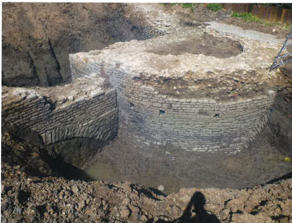
Fig. 2: Foto van de veldzijde van de Pijntoren. De gaten voor de stellingen (centraal) en de aanzet van de spaarboog in de voorzijde (rechts) zijn hierbij zichtbaar. Links is ook een deel van de stadsmuur met spaarboog zichtbaar
