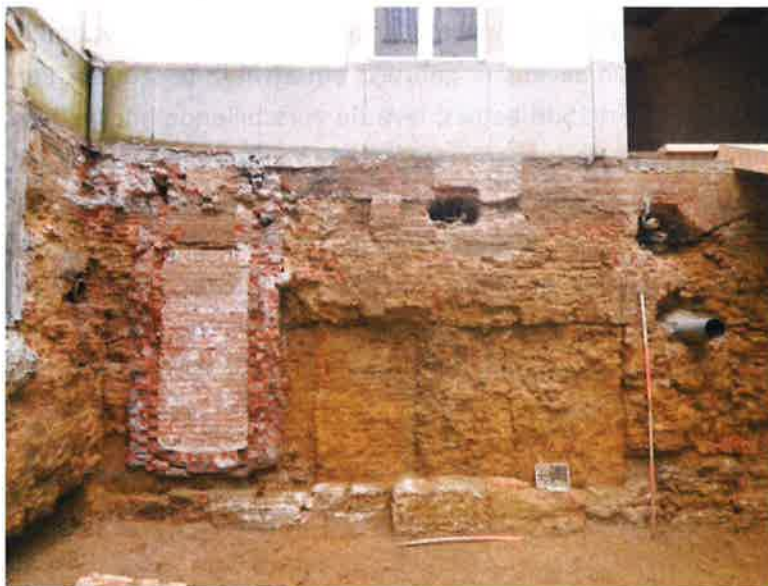
Fig. 3: Zuidelijk bouwvolume ter hoogte van de westzijde van de binnenkoer met vermoedelijk 17de- of 18de-eeuwse onderschoeiing. Onderaan de onderschoeiing uit 1954
