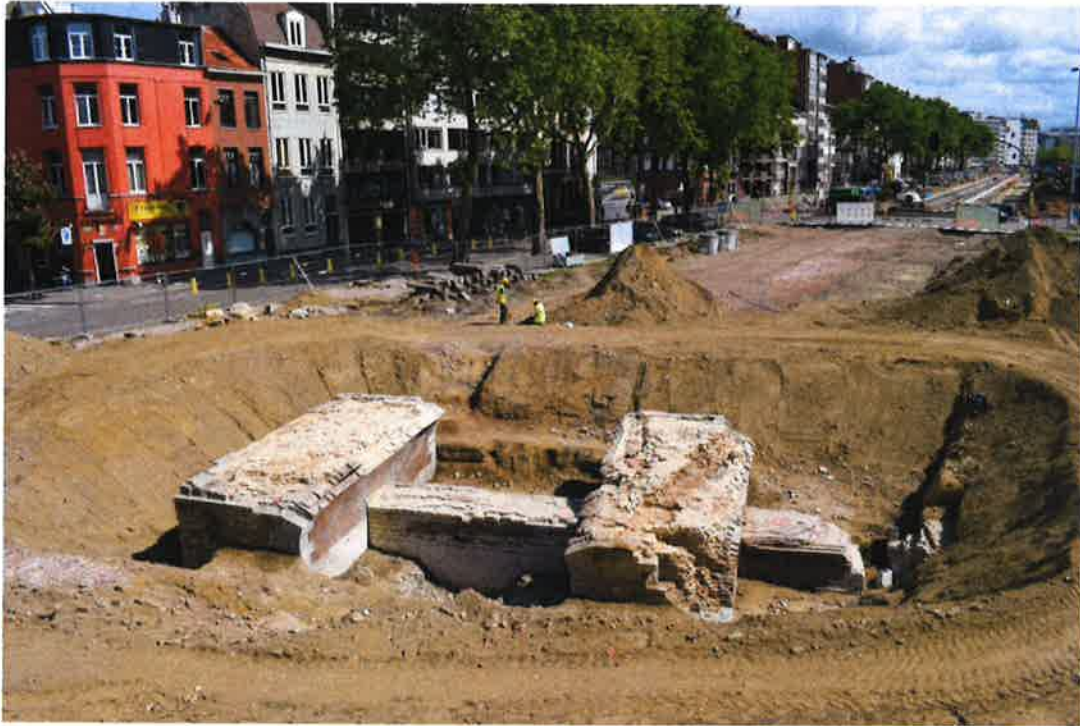
Fig. 3: Gezicht op 2 pijlers van de Rode Poortbrug met keermuren van de Houwer en sluisinfrastructuur
