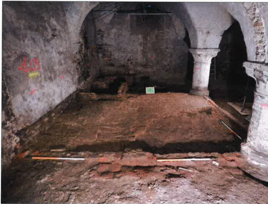
Fig. 3: Overzichtsfoto van vloerniveau in bouwvolume S215
