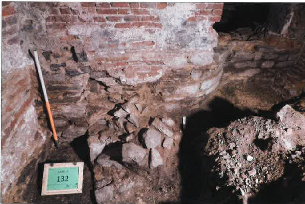
Fig. 3: Overzichtsfoto van S110 en S127, via afgerond metselwerk verbonden met volume S105
