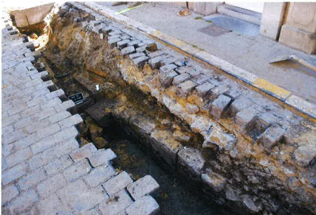
Fig. 2: le mur arasé dans la rue d'Austravant avec, en ressaut, ce qui pourrait être un corbeau du dispositif de la porte du même nom (photo : F. Chantinne, © SPW/Patrimoine)
