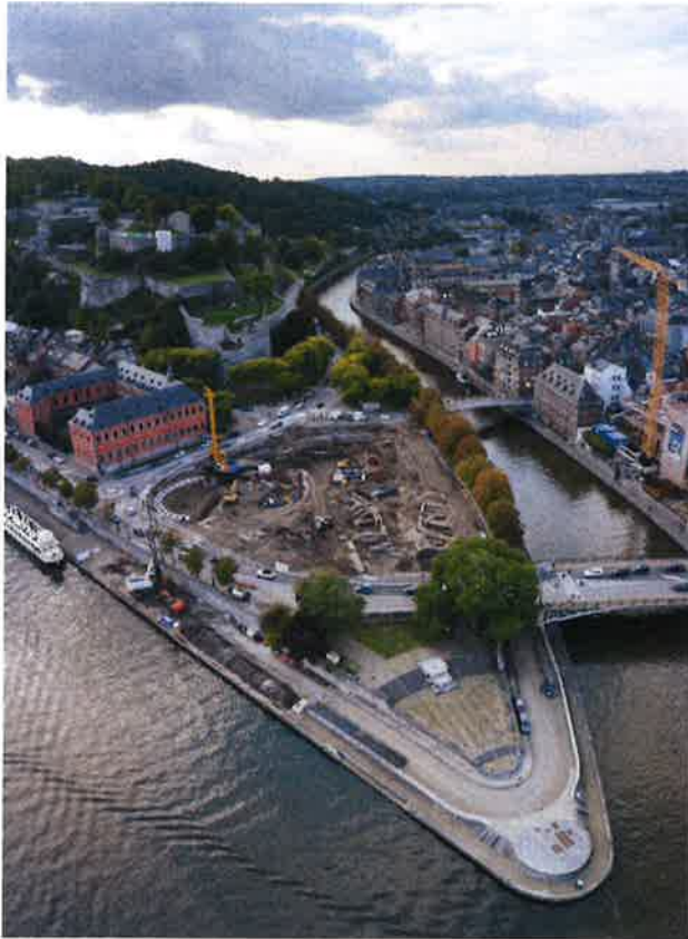
Fig. 1: Le Grognon en travaux : archéologie préventive et construction du parking souterrain, entre Sambre et Meuse (Photo : P.-M. Warnier – SPW/DGO4-Dir. Géomatique)
