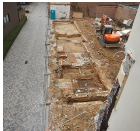
Fig. 3: Overzicht van de ruimtes langs het Maalderijstraatje na het weghalen van de vloeren. Op de voorgrond de mogelijke haringhangen.
