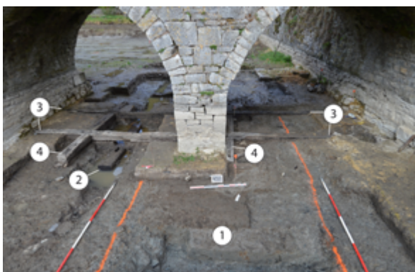
Fig. 5 : Vue globale des vestiges enregistrés en 2016 sous le pont de pierre. Phase médiévale : 1. Fossé (délimité par les lignes en orange) ; 2. Poutre de fondation d'une passerelle. Phase des Temps modernes (début xvii e siècle) ; 3. Poutres longitudinales ; 4. Traverses. Photo C. Frébutte © SPW
