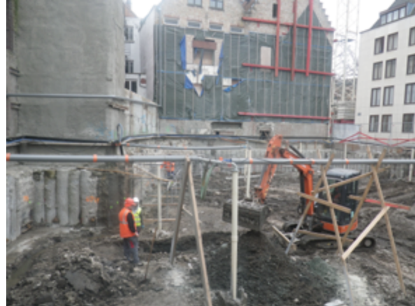
Fig. 1: Een sfeerbeeld van de onderzoekszone bij de aanleg van sleuf 2. De ondergrondse obstakels (pijlers en wateroverlast) zijn nog veel groter dan de bovengrondse (grondbemaling).
