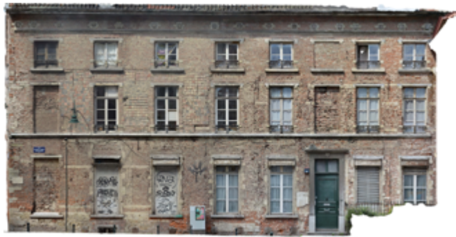
Fig. 2 : Couvent des Riches-Clares, aile méridionale, relevé photogrammétrique de la façade longeant la rue des Riches-Clares (S. Byl, F. Huyvaert © SPRB-ULB).
