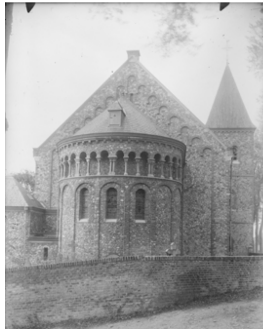
Fig. 2. L'église après les restaurations. © KIK-IRPA.
