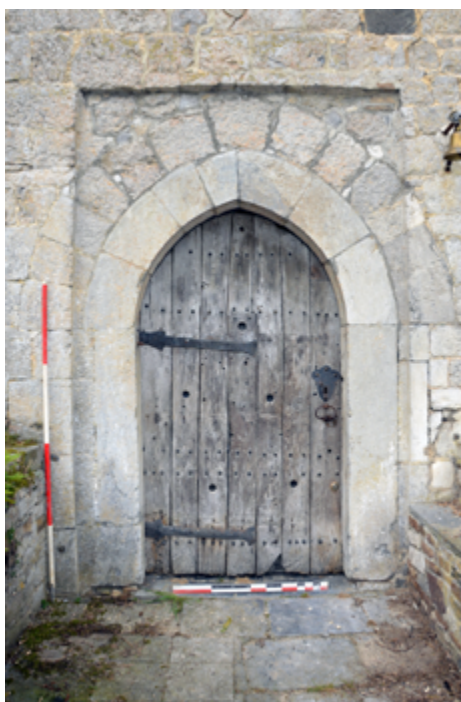
Fig. 4 : Porte d'accès à la maison forte. Photo C. Frébutte © SPW
