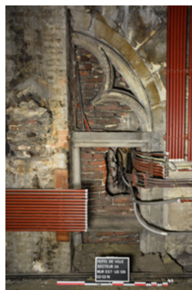
Fig. 1 : Hôtel de Ville de Bruxelles, aile occidentale, vue partielle d’une fenêtre gothique datée de la phase de construction commencée en 1444 (S. Byl, F. Huyvaert © VB-ULB).
