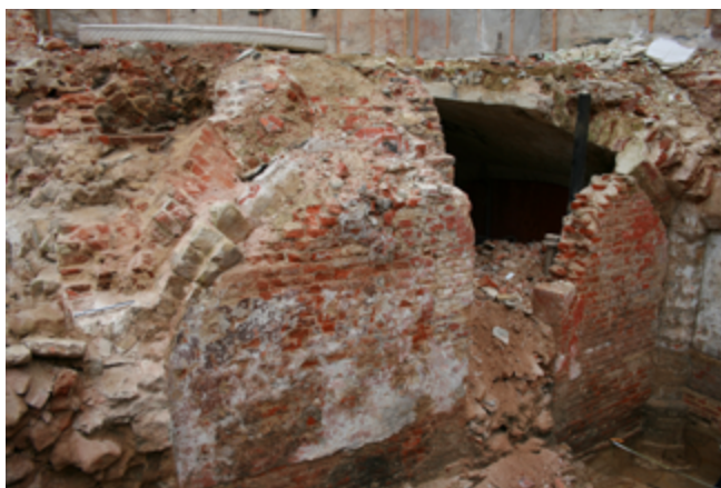
Fig. 1 : Vue générale de la cave du n° 36 de la rue de l'Escalier à 1000 Bruxelles, datée entre 1400-1450, photo : P. Sosnowska © ULB)
