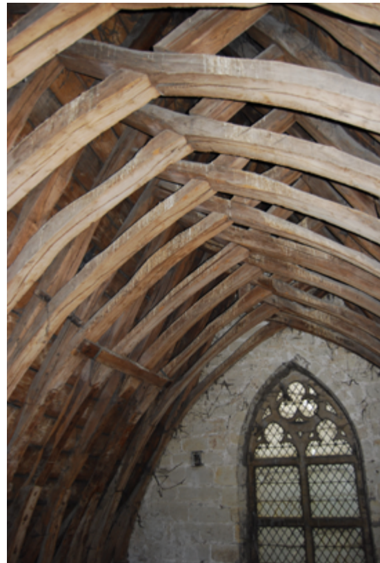
Fig. 2 : Charpente couvrant l'ancien porche, chapelle sud de la collégiale des Saints-Pierre-et-Guidon à Anderlecht © SPRB (photo : A. Weitz, 2016)
