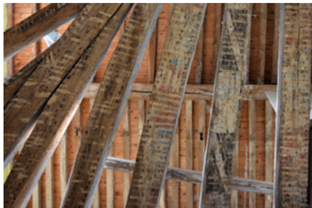
Fig. 3 : Poutraison du plafond du 2e niveau avec traces de peintures. Photo J.-L. Javaux.
