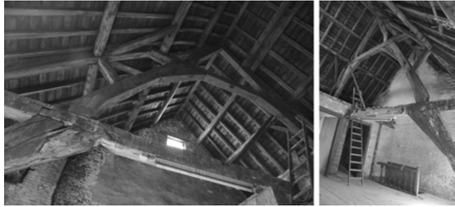
Fig. 2 : Volume A, ferme de charpente II. © SPRB, MRAH – 2016
