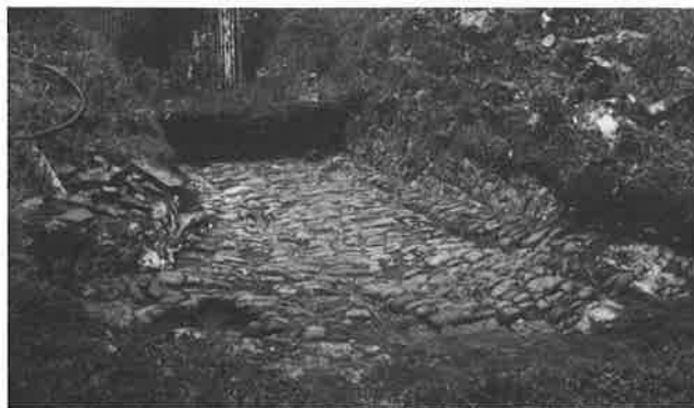
Fig. 7 : MONTAIGLE : Chemin d'accès.
