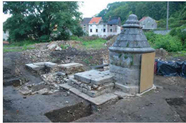
Fig. 3 : Vue des structures dégagées. L'accès à la tourelle d'escalier est provisoirement condamné et sera pourvu d'une porte ou d'une grille (© SPW-DGO4).
