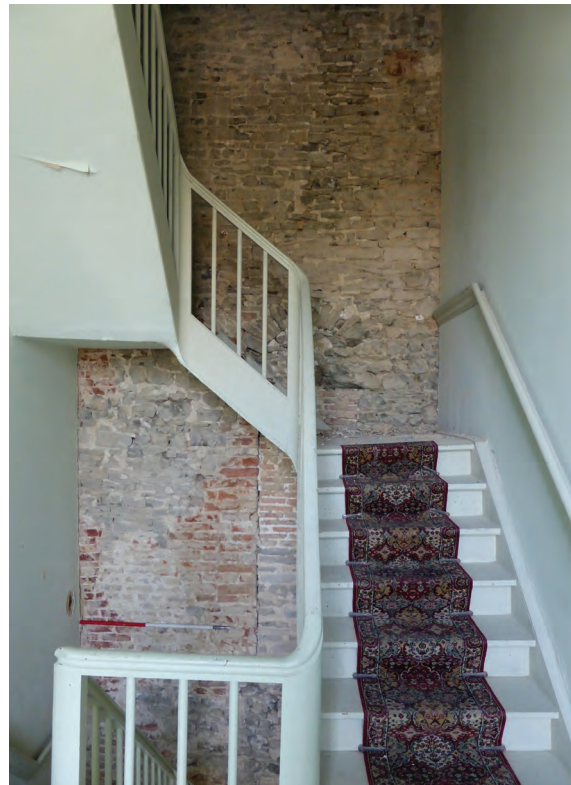
Fig. 2: Foto van ontleisterde muur. Bemerkt net boven de overloop van de trap de rondboog en daaronder de linkse deurstijl in baksteen van groot formaat.
