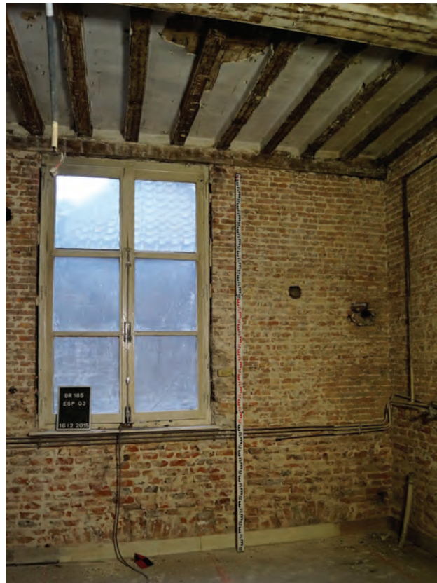
Fig. 3 : Rue Marché-aux-Herbes 8-10 : façade arrière, maçonnerie construite en brique de remploi et briques d'importation.
