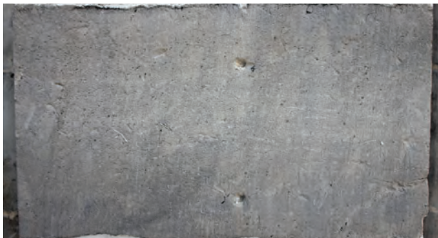
Fig. 3. Une des rares pierres arborant deux trous de pince sur le même parement. © A. Baudry
