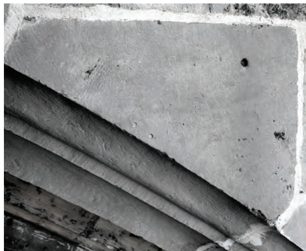
Fig. 1. Une des pierres composant la courbure de l'arc d'une des trois baies de la façade. © A. Baudry
