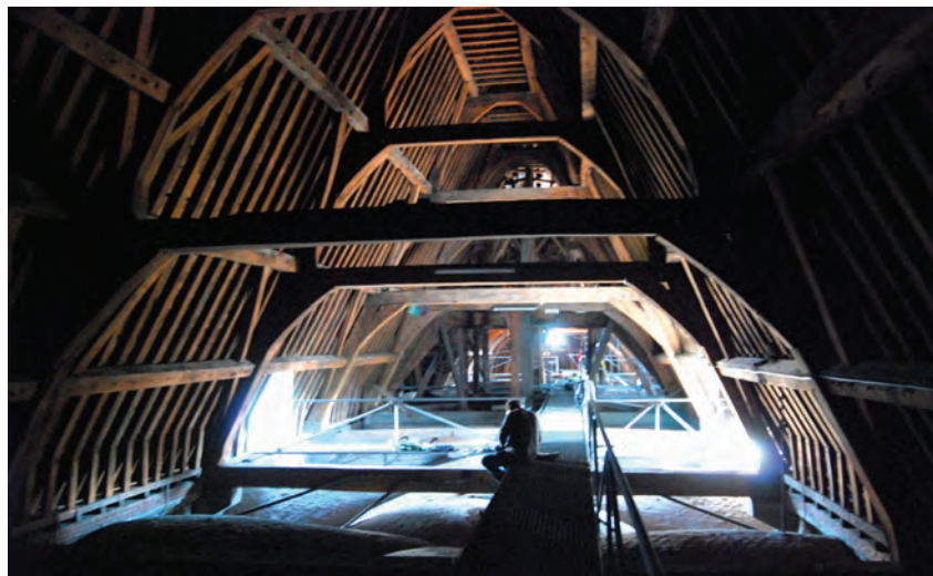
Fig. 1 : Vue de la charpente de la nef de l'ouest vers l'est (photo : A. Weitz © SRPB).
