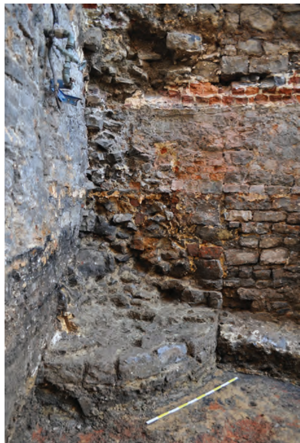
Fig. 3 : Tourelle de flanquement de la Porte en Vis (Deuxième Enceinte) (Photo. : O. Vrielynck – SPW/DGO4-Direction de l'Archéologie).
