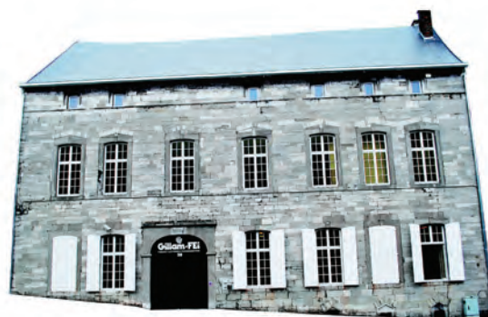
Fig. 1 : état actuel et essai de reconstitution de la façade méridionale de la maison n° 58, Mont Saint-Martin à Liège, durant la seconde moitié du XIV e siècle.
