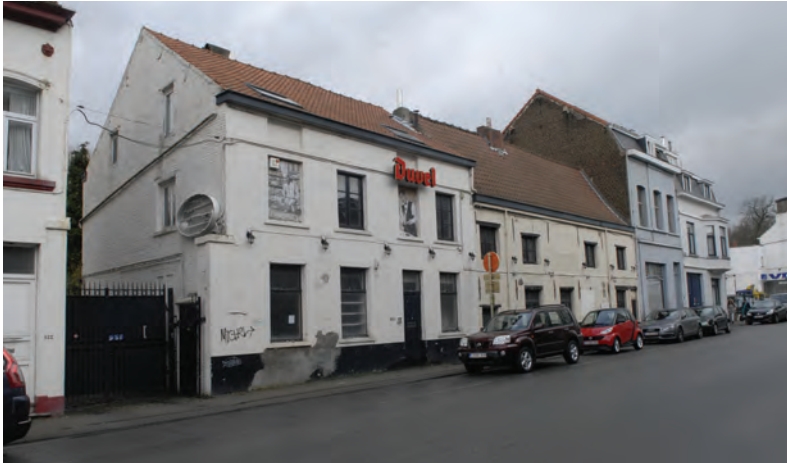
Fig. 1 : Les deux volumes actuels, chaussée de Waterloo 824-830.
