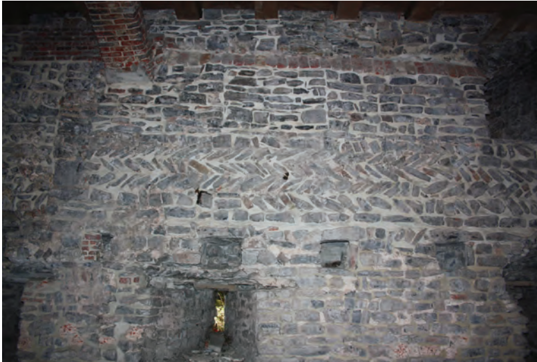
Fig. 1: Detail van muurwerk in de stenen residentie van het Gravensteen (Stad Gent, De Zwarte Doos, Stadsarcheologie)
