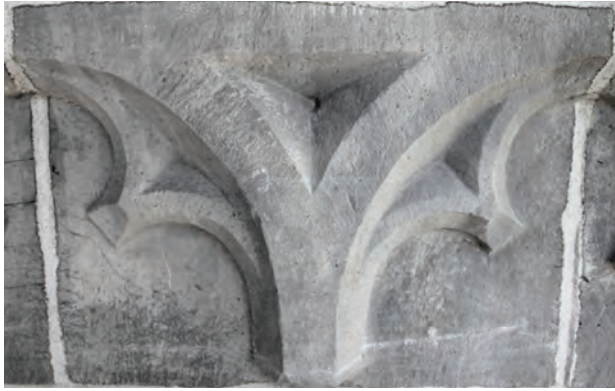
Fig. 2. Un des 22 blocs standardisés de la frise d'arcature couronnant la façade. © A. Baudry
