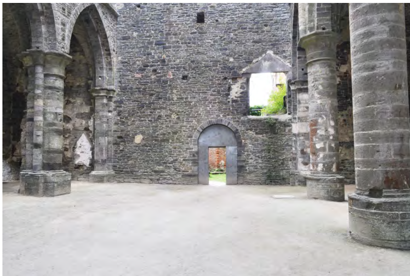
Abbaye de Villers, mur pignon du transept sud de l'église. En hauteur, la porte qui donnait accès au dortoir des moines directement depuis l'église et vers laquelle menait l'escalier de nuit aujourd'hui disparu. Au niveau du sol, la porte cintrée ouvrant vers la sacristie
