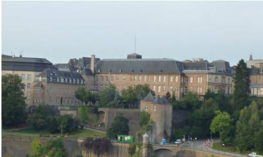
La façade arrière présentant l'ancien Hôtel du Gouverneur et la porte médiévale des Trois Tours, relié par le bastion de 1606
