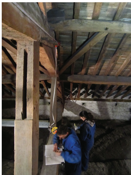
Fig.2 : Réalisation d'un relevé en coupe transversale d'une ferme de la charpente de l'église Saint-Nicolas, Neder-Over-Heembeek © Modrie S., DMS.
