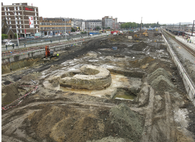
Fig. 2. La tour médiévale et l'ensemble de la zone sud.
