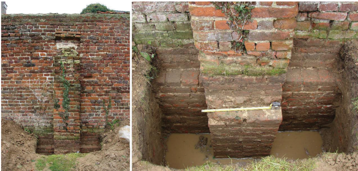
Fig. 3. Funderingsput 4 aan de abdijskant van de Lange Muur (A) ter hoogte van een van de steunberen.
