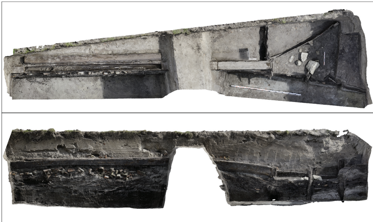
Fig. 1. Middelburg-Kasteelstraat. Grondplan (boven) en doorsnede (onder) van het overstort dat zich in de courtine van de oudste stadsbastionering bevond, en een verbinding realiseerde tussen kasteelgracht en stadsgracht. (Beeld: Jeroen De Reu, Vakgroep Archeologie, Universiteit Gent).
