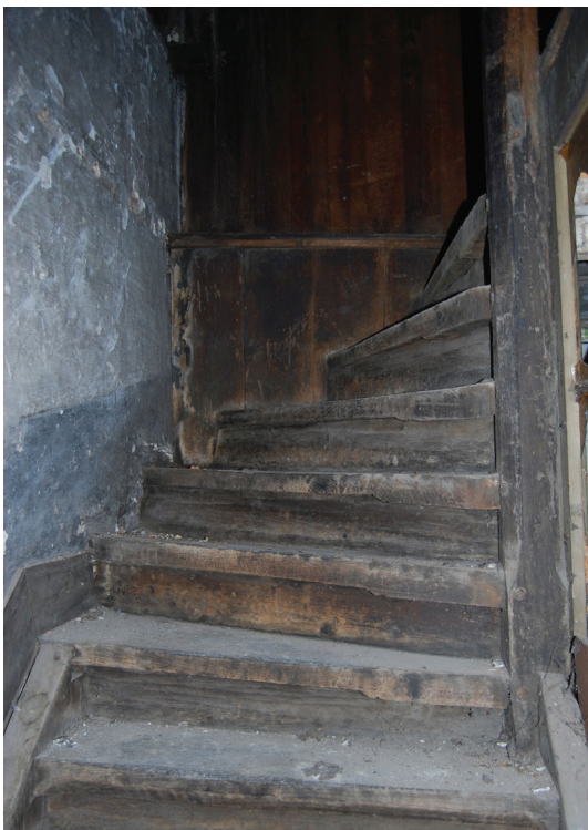
Fig.3 : Exemple d’aménagement intérieur pouvant être intégré à l’étude d’un bâtiment. Escalier menant aux combles, Maison, rue du Marché-aux-Herbes 8-10, Bruxelles © Weitz A., ULg-IRPA.
