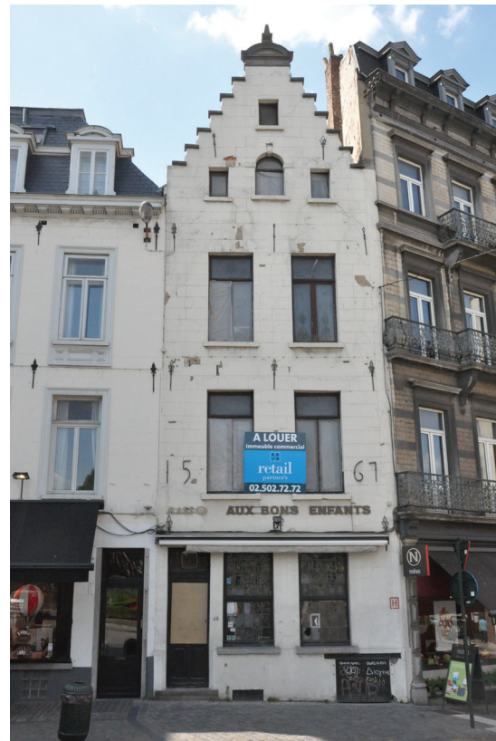
Fig.2. Place du Grand Sablon 49, vue de la façade à rue (S. Byl © MRBC).
