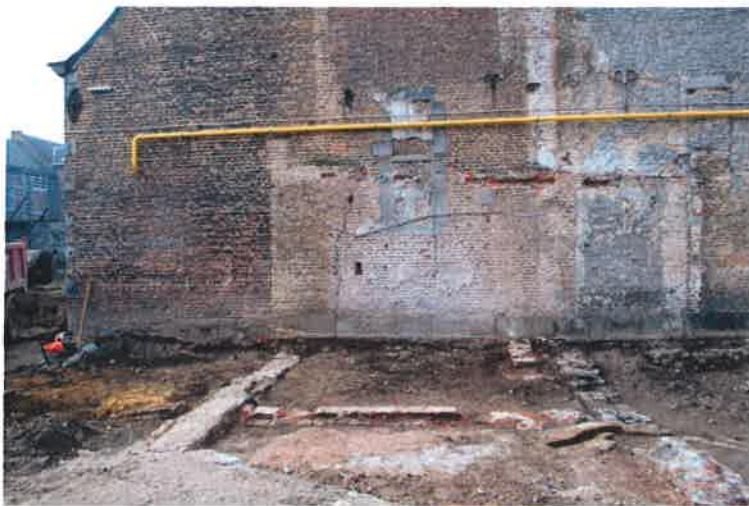
Fig. 2 : Vue du bâtiment en brique, à l'arrière de l'aile nord-est, vers le sud-ouest (Michel Siebrand © SPW/DGO4/Direction extérieure de Namur/ Patrimoine/ Direction de l'Archéologie).
