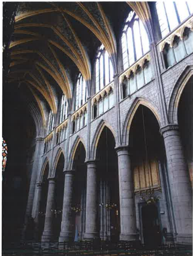
Fig. 1 : Nervures et triforium en calcaire Bajocien de la cathédrale Saint-Paul à Liège.
