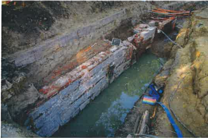
Fig. 1: Zicht op de kademuur in de tweede sleuf.
