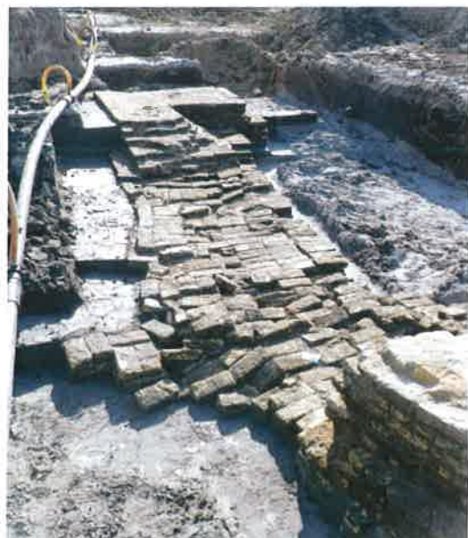
Fig. 3: Funderingen van het poortgebouw (1ste helft 14de eeuw). Zichtbaar zijn de noordelijke zijmuren met aan weerszijden stevige steunberen
