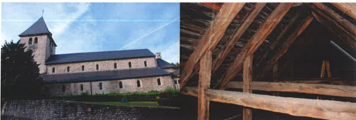
Fig. 3 : Woluwe-Saint-Lambert, église Saint-Lambert, Charpente couvrant la partie occidentale de la nef.
