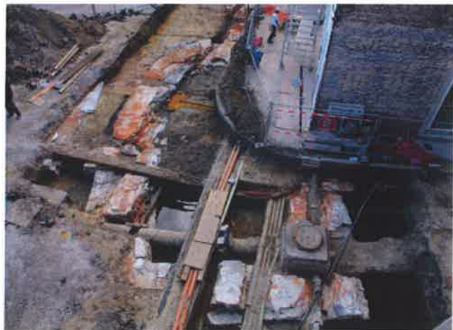
Fig. 3: Zicht op de westelijke toren.
