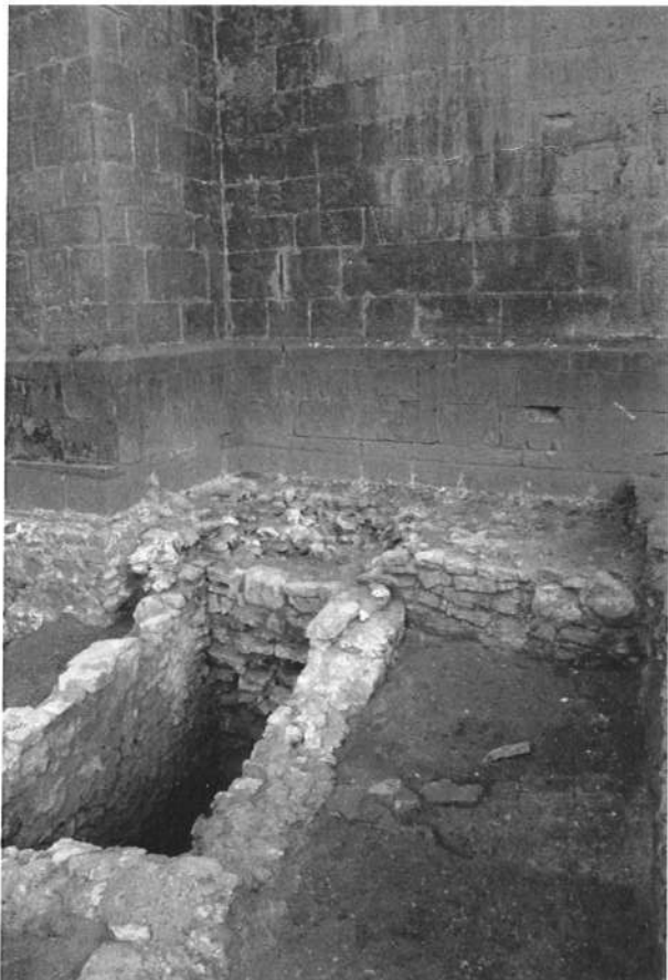
Fig. 3 : À l'arrière-plan, fondations et élévations de la tour et d'un de ses contreforts ; à l'avant-plan, l'habitat et ses latrines (Photo D.Ingels © SPW).
