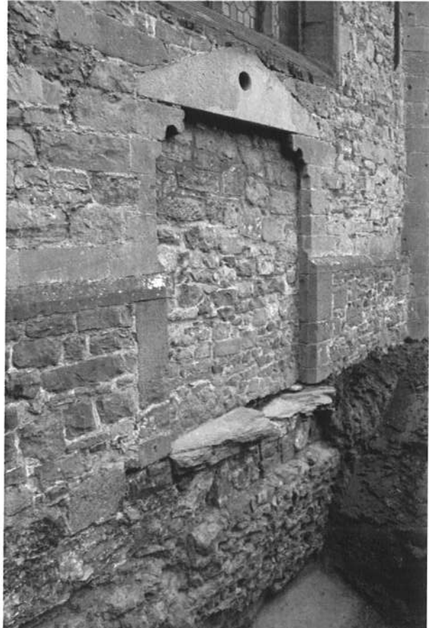
Fig. 2 : Façade nord du bas-côté nord : fondation, élévation et porte (Photo D.Ingels © SPW).
