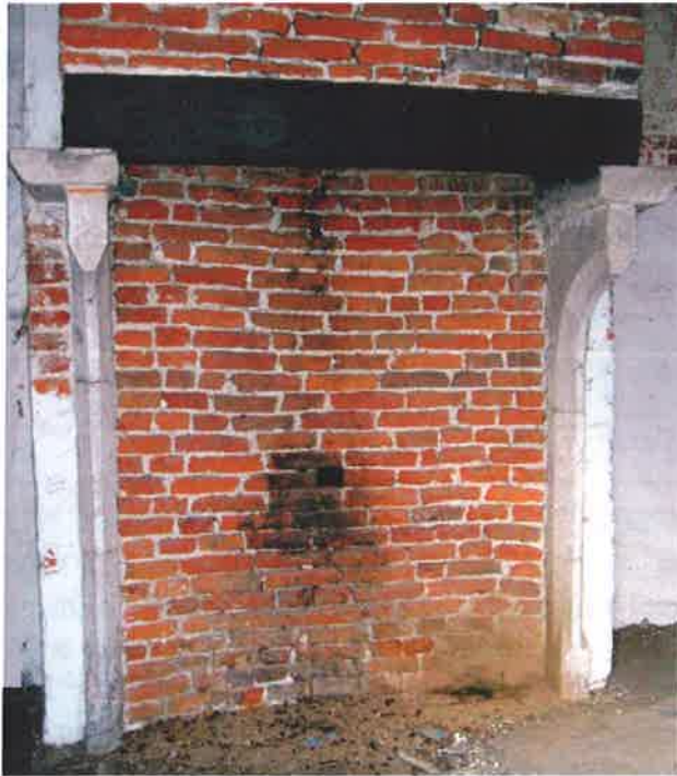
Fig. 2 : Cheminée en calcaire et briques surmontée d'un linteau de chêne ( Quercus sp. ); Leuven, maison « De Lusthof », Parijsstraat n°38, 1er étage, pièce est ; étude dendrochronologique pour J. Grootaers (n° dossier IRPA 2012.11531 ; n° dendro. IRPA P490). © Cell. Dendro., IRPA
