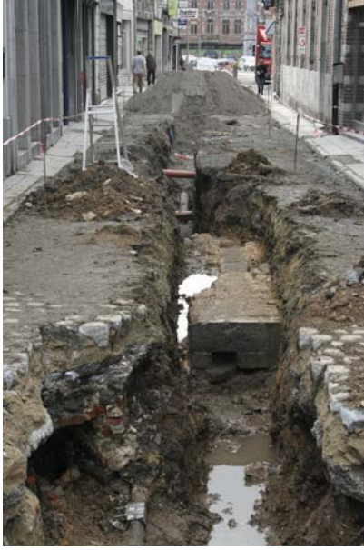
Fig. 2 : La base de la porte de Virelles, avec en son centre le canal d'évacuation des eaux. (Photo : B. Van Nieuwenhove □ SPW/DGO4)
