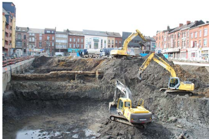
Place de la Digue en cours de terrassements, vue est
