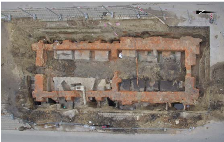
Fig. 6: Overzichtsfoto op de stadshal. In het zuiden is de systematische opbouw van steunberen en poeren zichtbaar. In het noorden wordt deze bedekt door een latere verbreding van het fundament. © S. Vandecatsye, K. Laisnez & Nikki Heyerick (EEC)
