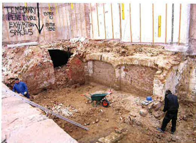
Fig. 2: Overzichtsfoto van kelder 1 met de nog overwelfde ruimte (links) en de vrijgelegde kalkzandstenen zuilen en bogen (rechts) (© MBHG-DML, foto B. Claes, 2010).
