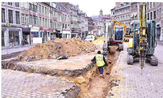
Fig.2 : Namur, place de l'ange : vue du chantier vers le nord-ouest.
