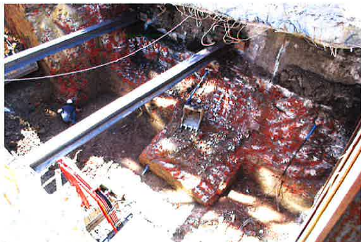
Charleroi, quai de Brabant, les vestiges du Bastion d'Amsterdam dégagés lors des travaux d'aménagement. Photo © SPW, Dir. du Hainaut I.
