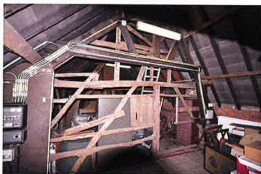
Fig. 3. Photographie de la ferme-pignon nord comportant encore les vestiges d'une ancienne baie de fenêtre (© Paulo Charruadas et Philippe Sosnowska, 2010)
