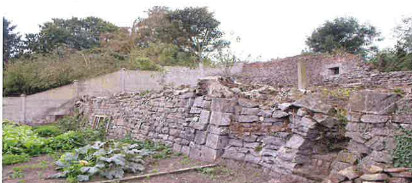
Fig. 1 Vue de la terrasse et de la courtine. Dolores Ingels @ SPW/DGO4
