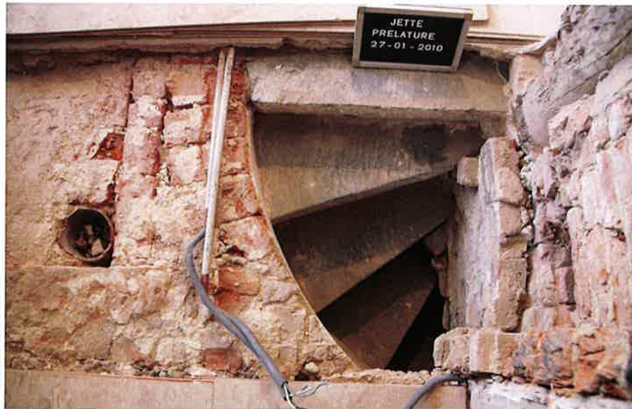
Fig. 1 : De vrijgelegde wenteltrap in de abt woning van Dielegem te Jette (foto S. Van Bellingen, © MBHG-DML)
