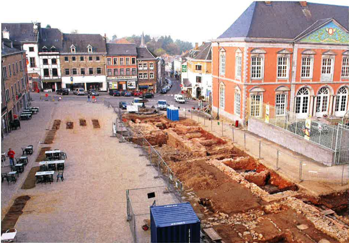
Vue générale du chantier en face de la basilique . Copyright SPW-DGO4- Henrotay D.
