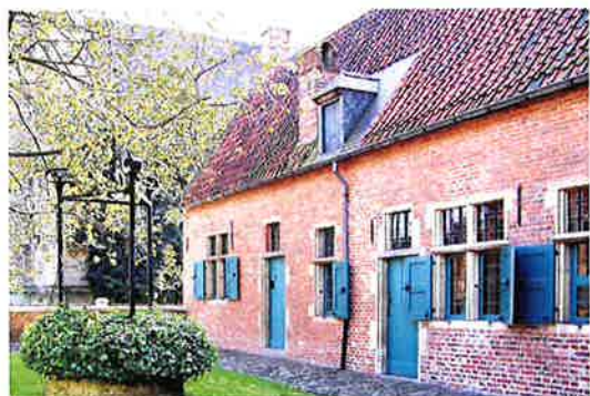
Fig. 2. Photographie actuelle de l'aile ouest du béguinage, façade est depuis l'intérieur de la cour (© Paulo Charruadas et Philippe Sosnowska, 2010)
