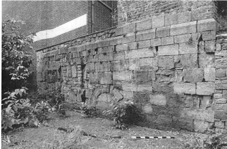
Fig. 1 : Dinant, rue Léopold. Vue générale du mur.
