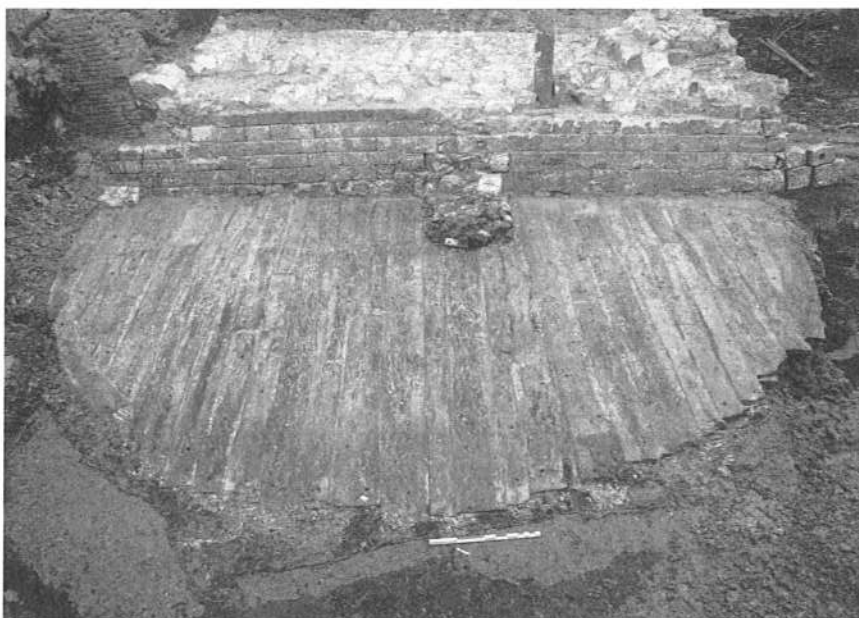
Fig. 1 : Radier de fondation de la tour de l'Angèle (milieu xv e -début xvi e siècle). En arrière plan, le mur de la première tour (état du xiv e siècle) (© INRAP).
