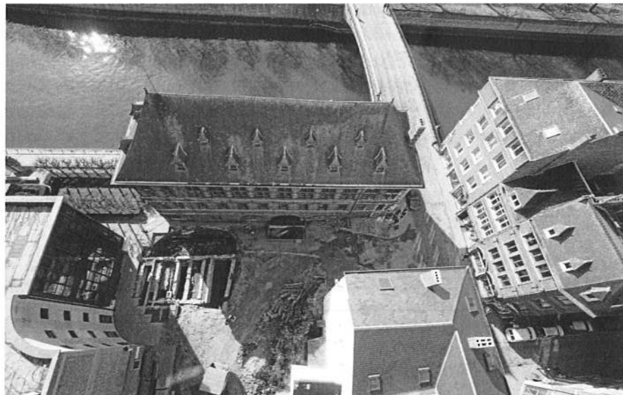
Fig. 1 : Vue aérienne, vers le sud, de la rue des Bouchers et de la « Halle al chair ». Mars 2009 (© Moers-Balloïde et SPW).
