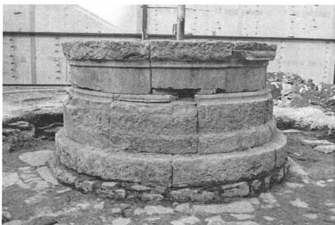
Fig. 2 : Le soubassement mouluré primitif de la fontaine et ses fondations après démontage des éléments en bronze et des structures postérieures au xv e siècle. (Photo C. Péters © SPW DGO4-Liège).
