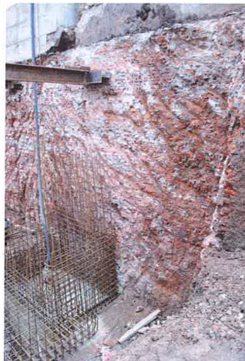
Fig. 1 : Charleroi, les maçonneries du Bastion d'Amsterdam (1816-1870) mises au jour sur 7 m de hauteur en bord de Sambre.
