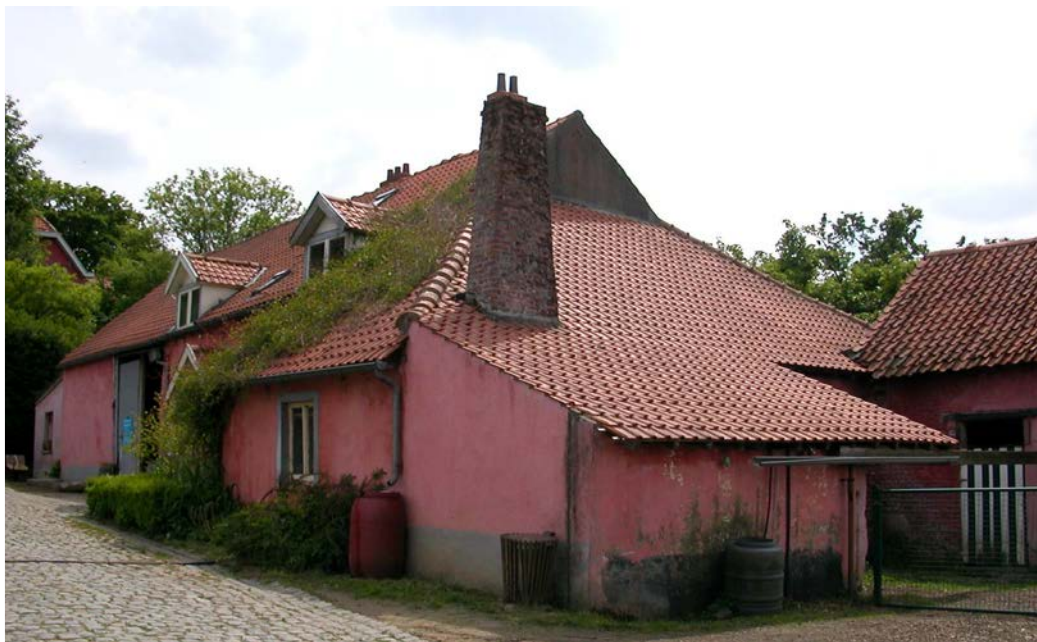
Fig. 1 :Ferme Fond'Roy en 2003 avant les travaux de rénovation. Vue vers le Sud. P. Gautier © - 2003
