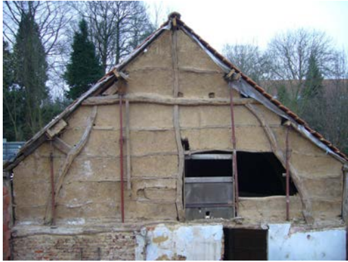
Fig. 4: Mur de refend à pans-de-bois et torchis millésimé 1832 (?) de l'ancienne ferme Fond'Roy durant les travaux de rénovation de 2008 de l'IBGE-BIM. P. Gautier © - 2008
