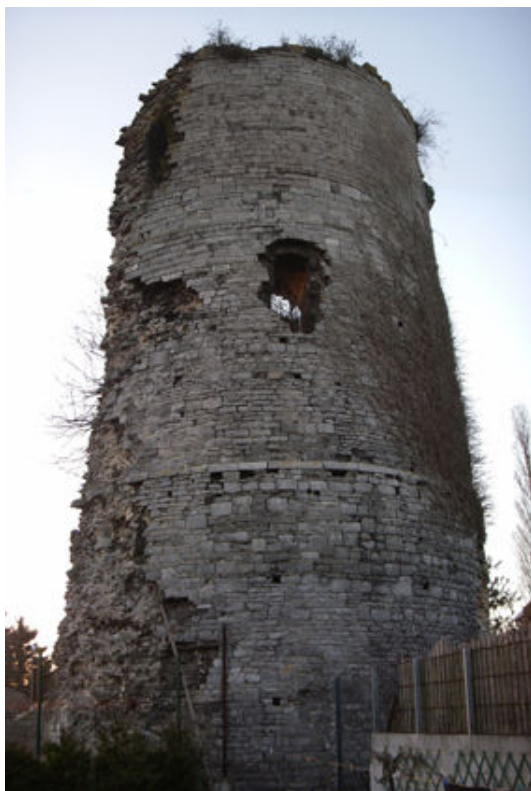
Fig. 3 : Vue de la Grosse Tour, prise de l'est (photo A. Henton, Inrap)
