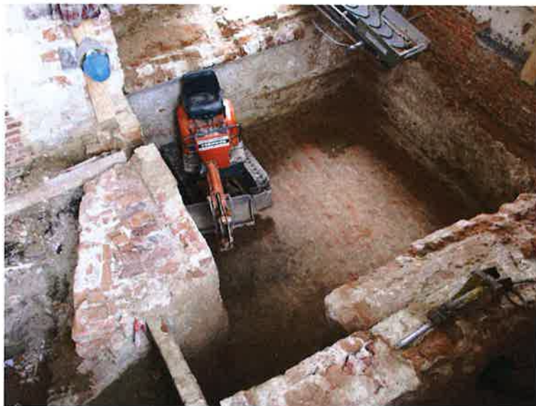
Fig. 3 : Zicht op de kelder uit fase 3.
