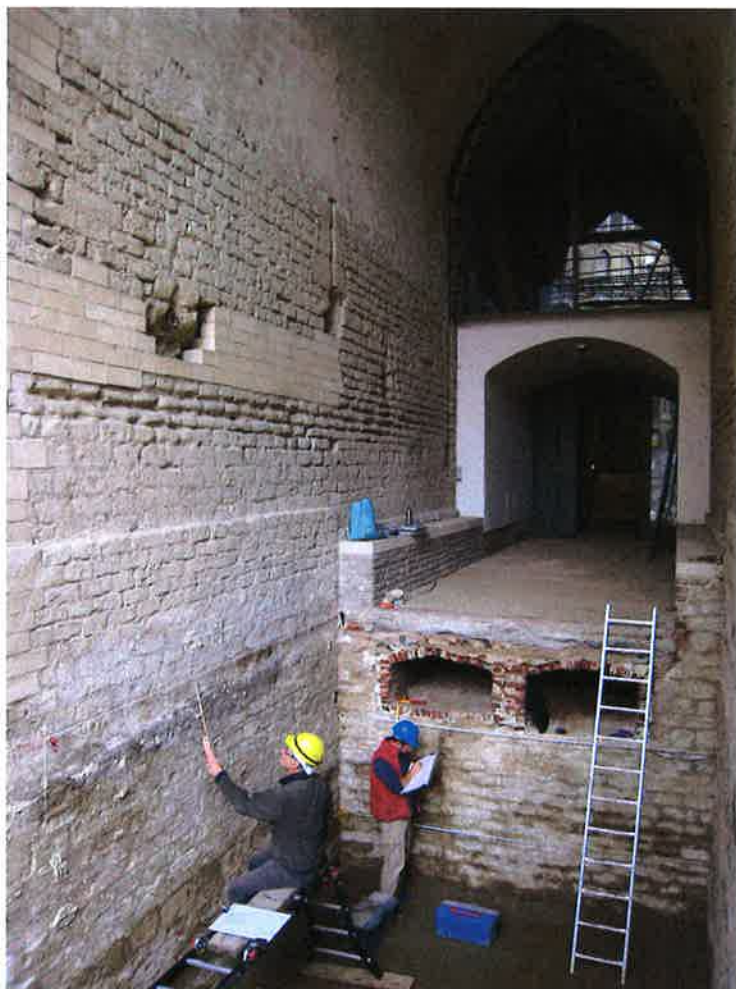
La fosse interne du pont-levis à bascule (© MRBC)
