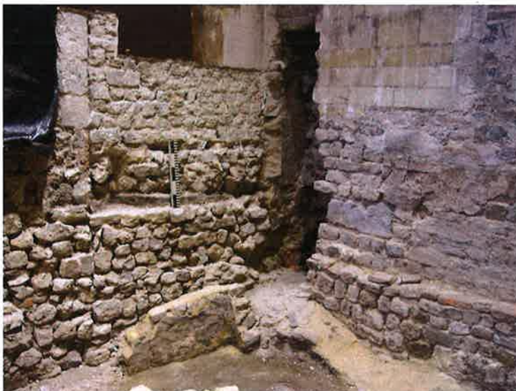
Fig. 5 : De 3 dichtgemaakte deuropeningen in de noordsacristie. In de hoek een recente koker voor een CV-schacht.
