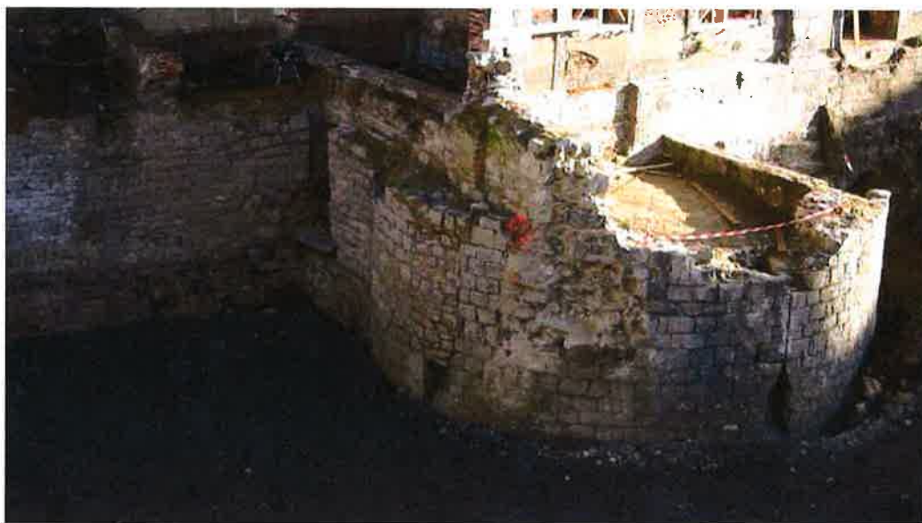
Fig. 1 : Tournai – Réduit des Dominicains. Structures liées à la première enceinte médiévale de Tournai. Mur de courtine occidentale et vestiges de la tour quadrangulaire, contre laquelle a été construite la tour circulaire.
