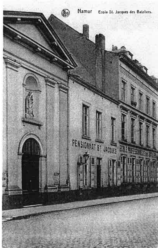
Fig. 1 : Ancienne École des Bateliers, à Namur : façade, rue J. Saintraint (carte postale ancienne).
