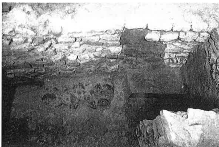
Fig. 1: Zuidelijke zijbeuk. Massieve muur in witte zandsteen met verschillende verbouwingen en onderaan oudste bouwfase in Doornikse kalksteen. Oversnijdt een uitgebroken muur in limonietbrokken (midden), een kindergraf (rechts) en een vroegmiddeleeuws graf (uiterst links). Onderaan is nog een tweede vroegmiddeleeuwse zichtbaar.
