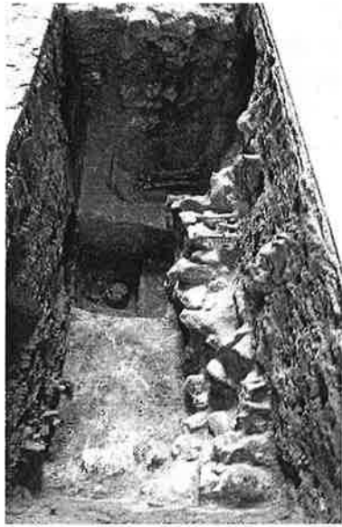
Fig. 2: Zicht op de nisvormig uitgebroken oostmuur voor het plaatsen van graven ter hoogte van het koorgedeelte.
