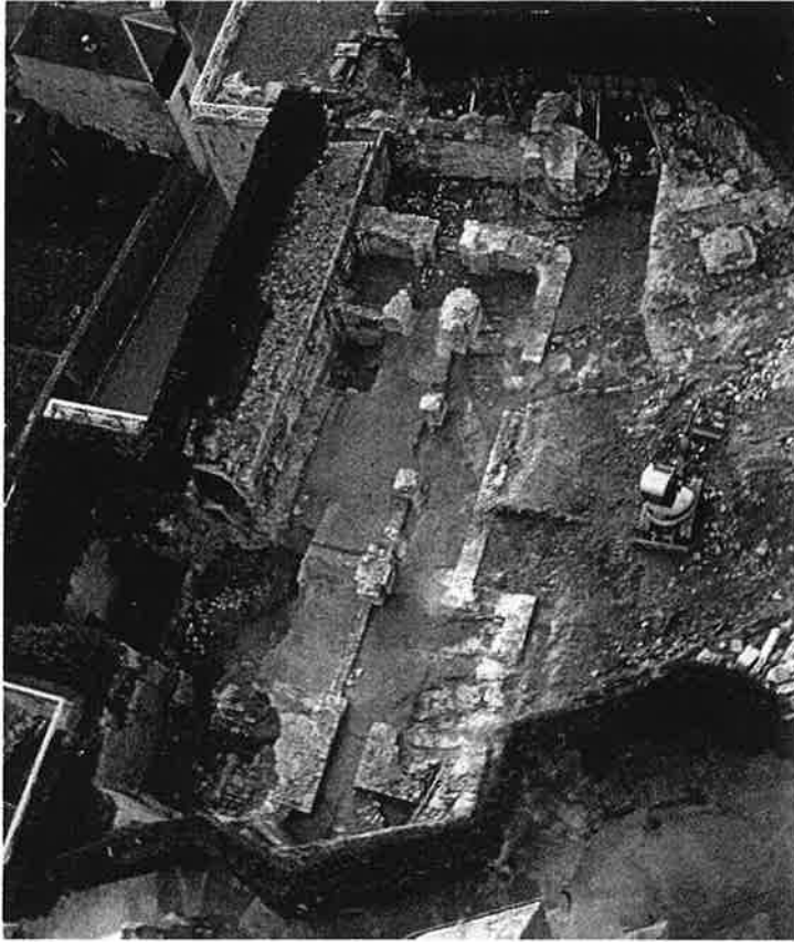
Fig. 1 : Vue aérienne du chantier et de la collégiale (P.-Ph. Sartieaux © MRW-DGATL)
