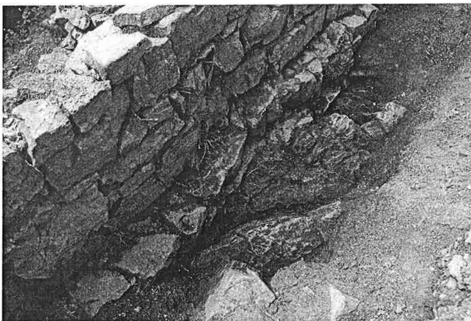
Tronçon de la courtine sud-est de la ville comportant une base
