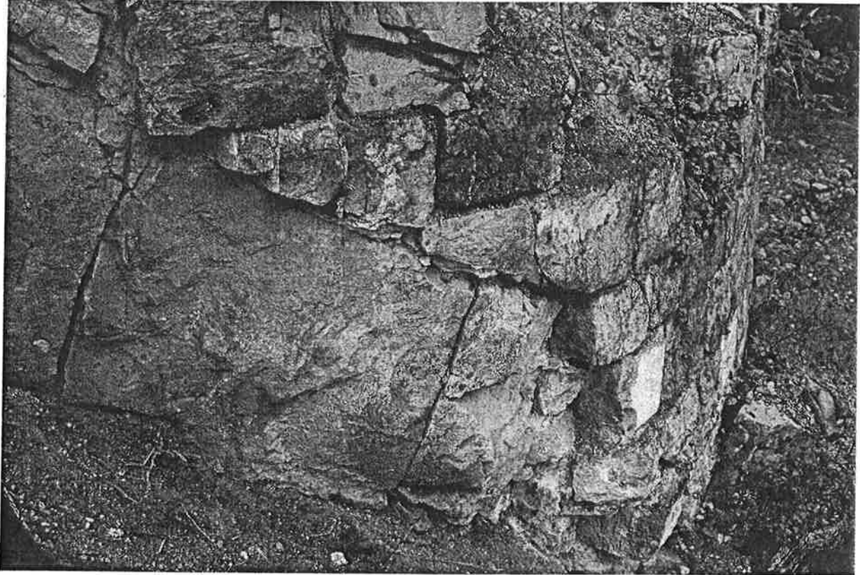
Implantation des premières assises de la tour du Nord sur le substrat rocheux
