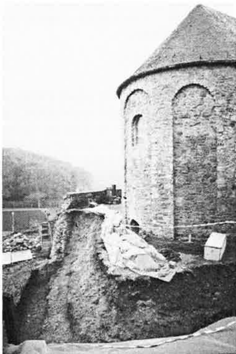
Suivi de chantier au chevet de la crypte de Thynes
