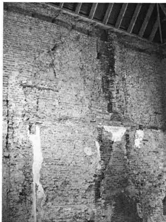
Zicht op de oostelijke muur, met de oorspronkelijke dakhelling en sporen van de (verdwenen) schouw"
