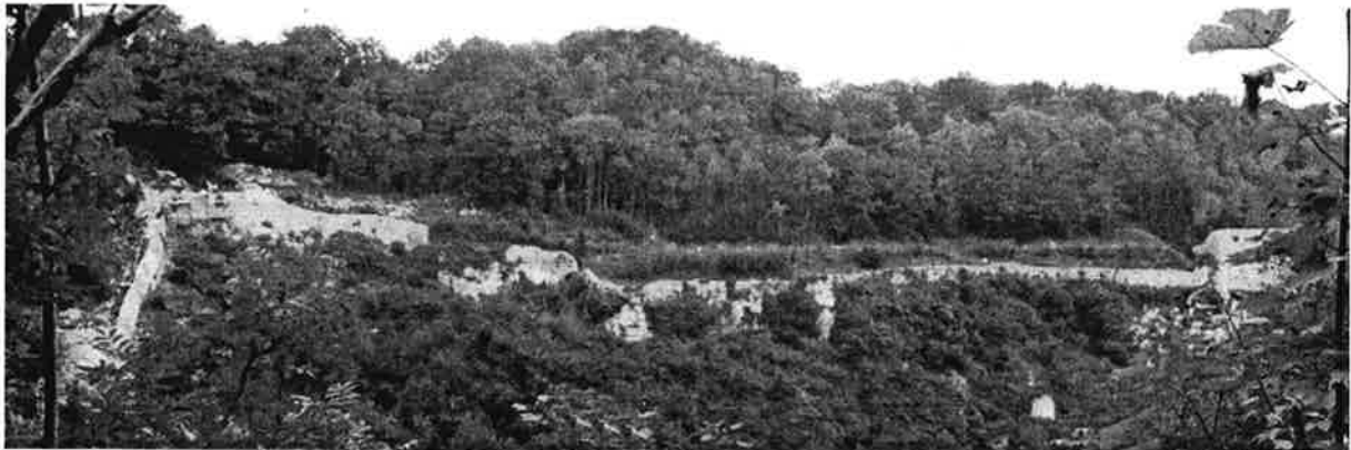
Fig. : Château de Samson à Thon (Andenne), le mur de courtine de la basse-cour depuis le sud.
