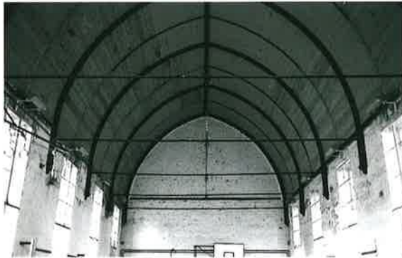
11. Intérieur de la salle des malades, dite Craeckhuys (Photo Département d'Archéologie Urbaine, Gand)
