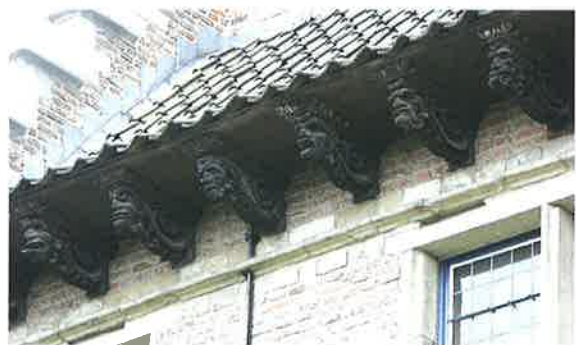
4. Les consoles en bois à masques soutenant la toiture de l'infirmerie des carmes, XVII e siècle (Photo Département d'Archéologie Urbaine, Gand)
