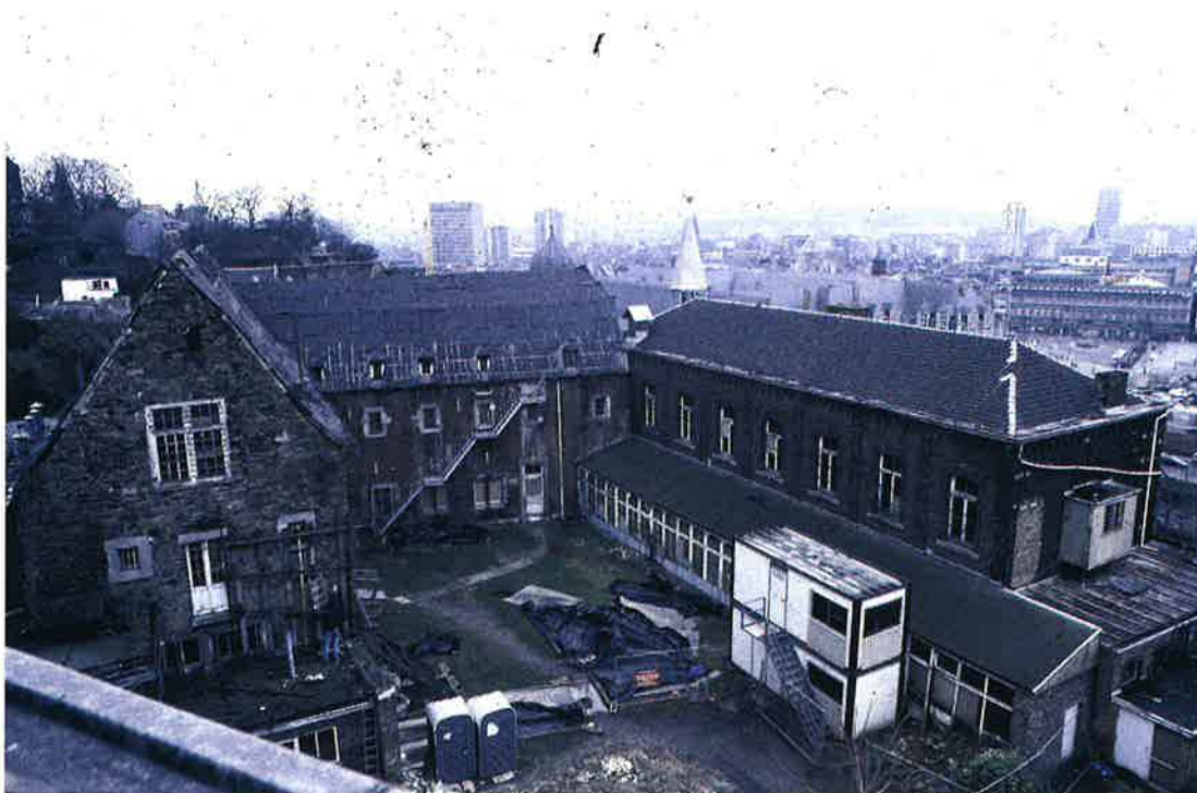
1. Vue générale du site (photo : Philippe Géron © In Situ – MRW, DPat)
