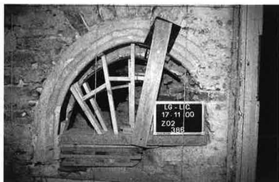
4. Baie en tuffeau à la modénature raffinée mise au jour sur le pignon oriental du bâtiment primitif (photo : Philippe Géron © In Situ – MRW, DPat).
