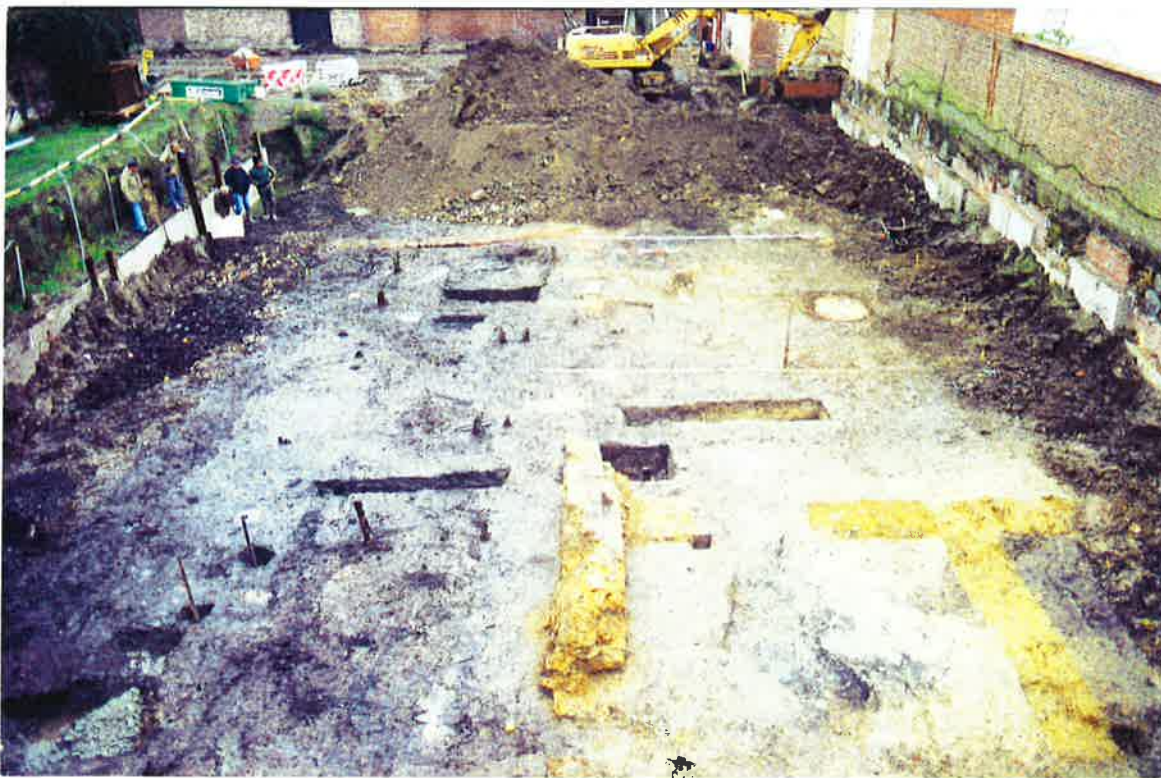
IEPER - Gevangenisstraat. Overzichtsfoto van de werf; rechtsonder : restanten van de ijzerzandstenen constructie; links : mestkuilen en houten constructies. De bakstenen constructies waren op poeren gefundeerd.
